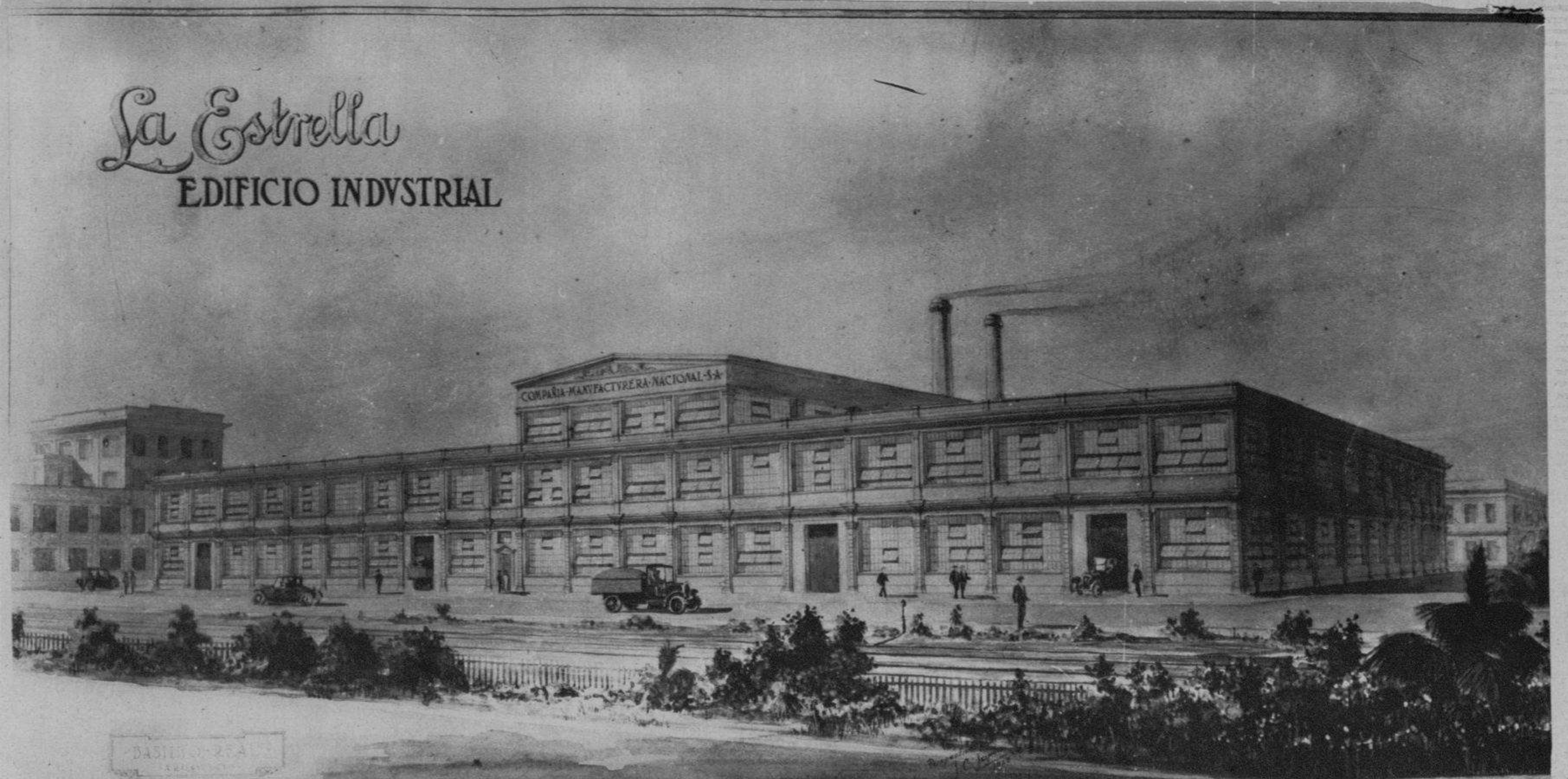
EXTERIOR del hermoso edificio que ocupa en la Calzada de Buenos Aires 35 la "Cuba Industrial y Comercial S. A.", donde se celebró la Convención Industrial de tan importante firma
