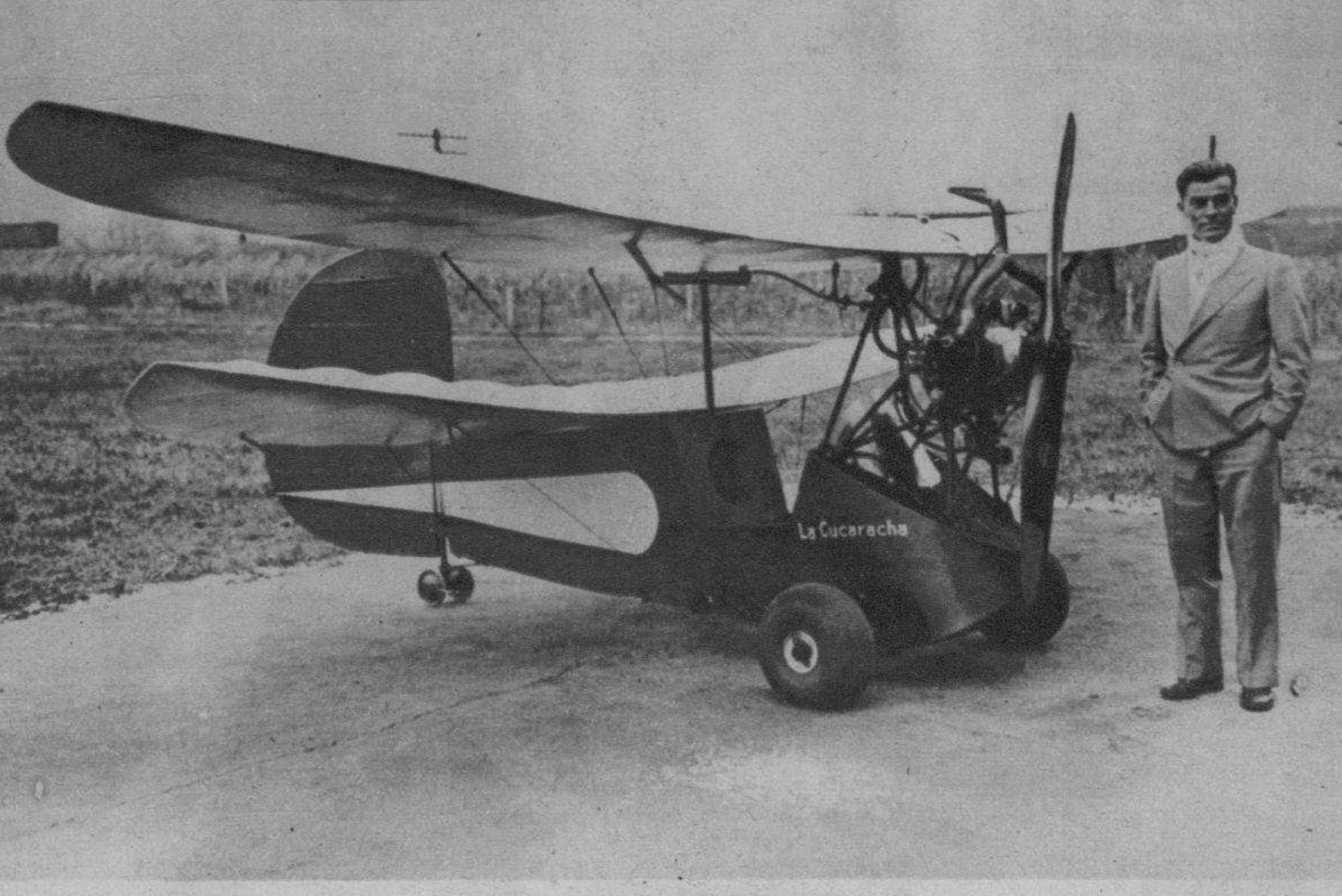
EDWIN MIRMAIER, de Ohio, ha construido, con la ayuda de dos mecánicos más, esta diminuta máquina, que costó, en total, la suma de 100 pesos. Pesa 316 libras, y tiene dos cilindros y un motor de motociclo. A bordo de "La Cucaracha", Mirmaier piensa lanzarse a las aventuras aéreas... sobre tejados y aceras de las calles (Foto Wide)
