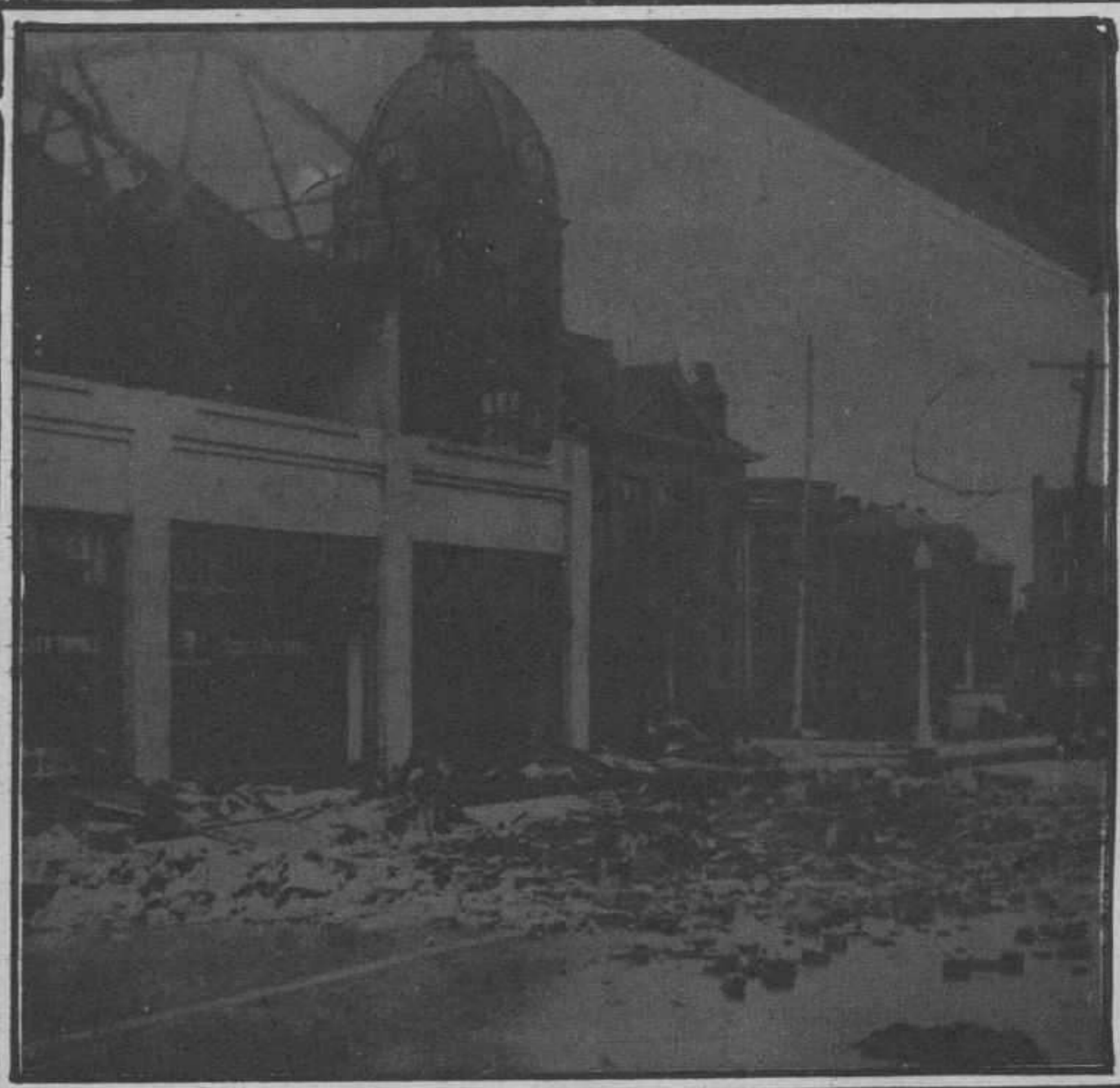
El paso de la furiosa galerna por el distrito comercial de Fort Pierce, en la Florida. Nótese los destrozos causados en los más sólidos edificios de ese distrito.
