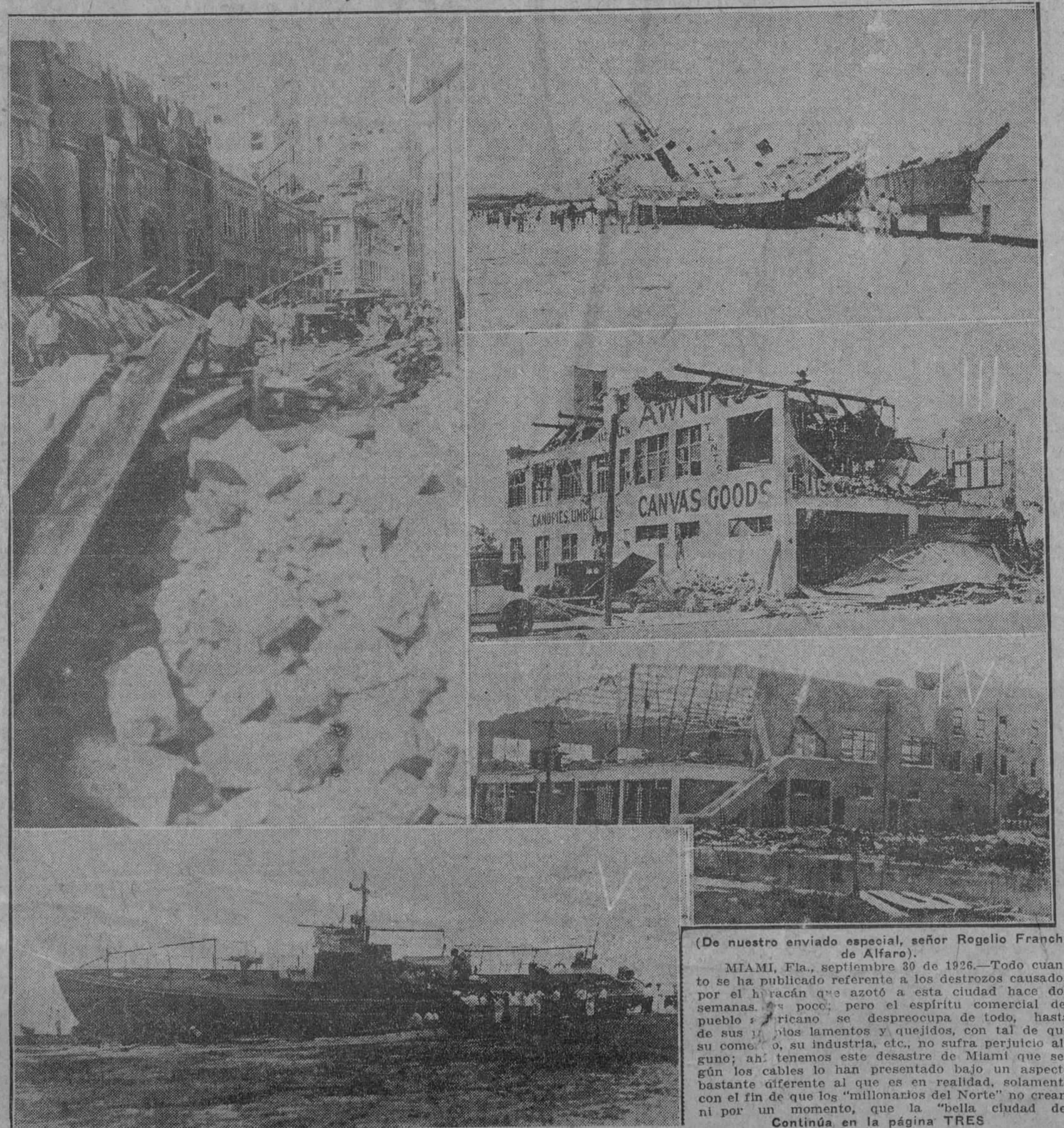
1 Kiser Bank, situado en la calle Noroeste, de varios pisos.—2 Un buque de 4,500 toneladas, arrojado por las olas, sobre la costa.—3 Estado en que quedó uno de los tantos edificios que en Miami se construyeron con cartón-cemento.—4 Droguería y establecimiento de viveres, en South West Eight Street destruido totalmente.—5 (Abajo) Guardacosta americano número 241, arrojado por las olas en la bahía, frente al parque.
