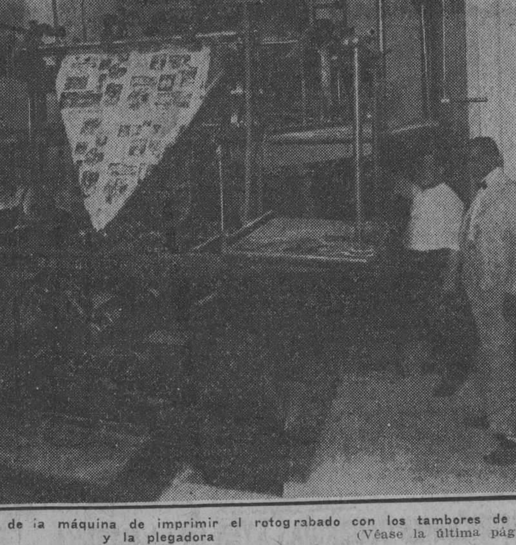
Nuestra fotografía presenta parte de la máquina el rotografado con los tambores de vapor y la plegadora (Véase la última página)
