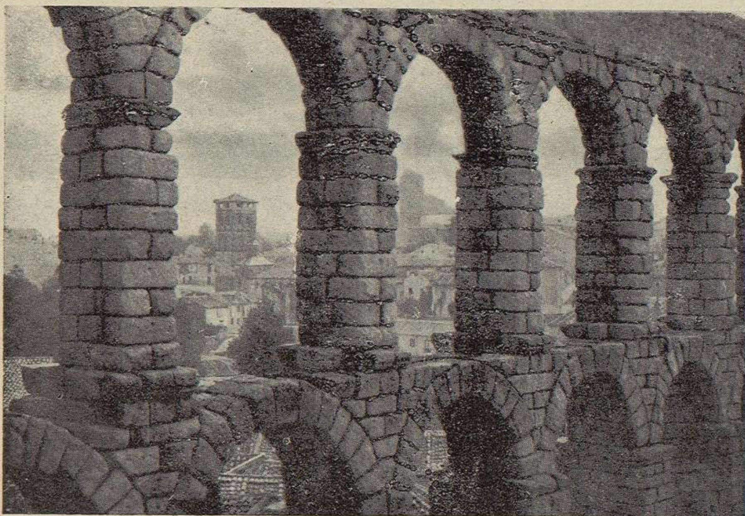
FIG. 2. a —Acueducto, visto desde el postigo de San Sebastián. A través de sendos arcos de la serie superior se divisan las torres de San Justo y del Salvador.
