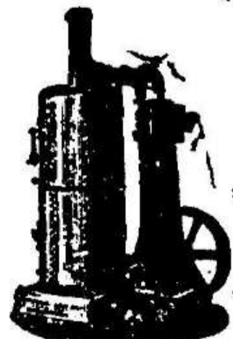
Máquina de vapor vertical.
