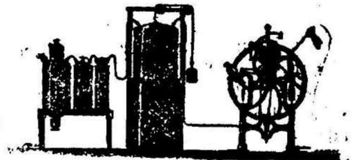
Aparato para gaseosas, continuo, con embotelladora, unidas.
