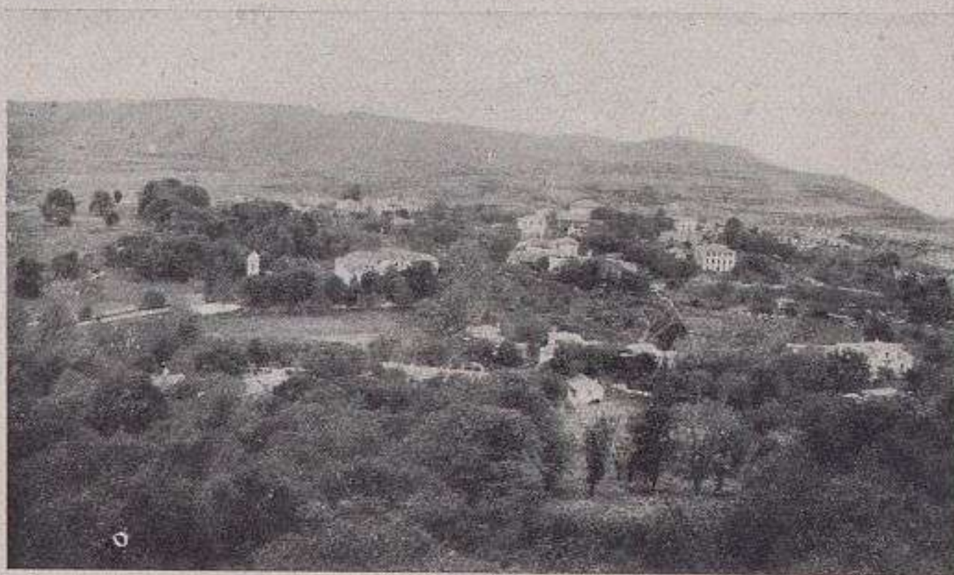
Fig. 1.—Vidiago, con sus palacios solariegos cobijados por espesas matas de seculares encinas...
