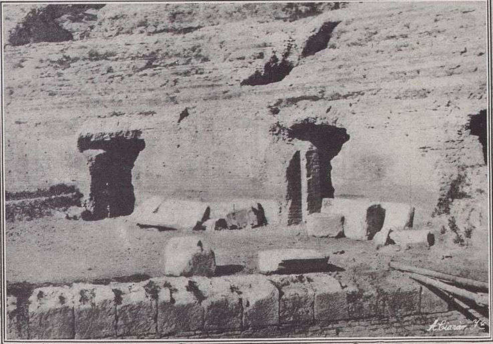
A. ESTADO EN QUE SE ENCONTRABA LA ARENA DEL ÁNFITEATRO. B. ESTADO ACTUAL.
