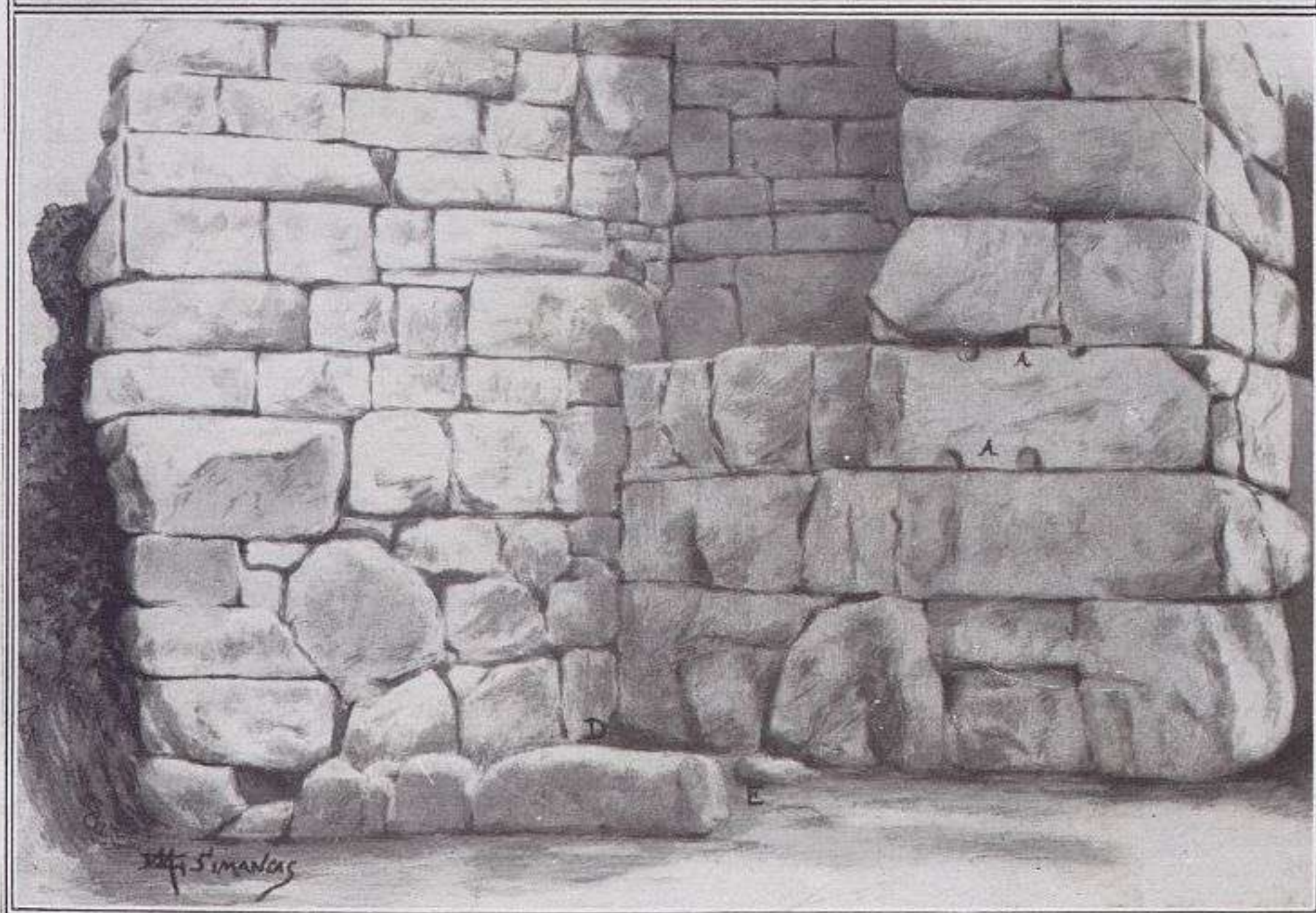
PARTE BAJA DE LA MURALLA CON LOS CONTRAFUERTES Y ZÓCALO
