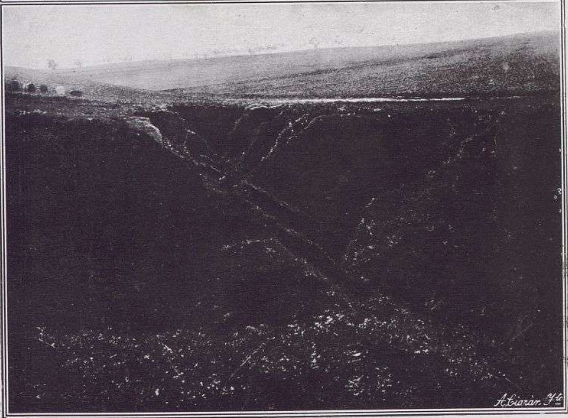
A. DESMONTE PARA DEJAR LIBRE LA FACHADA Y ENTRADA DEL ANFITEATRO.
