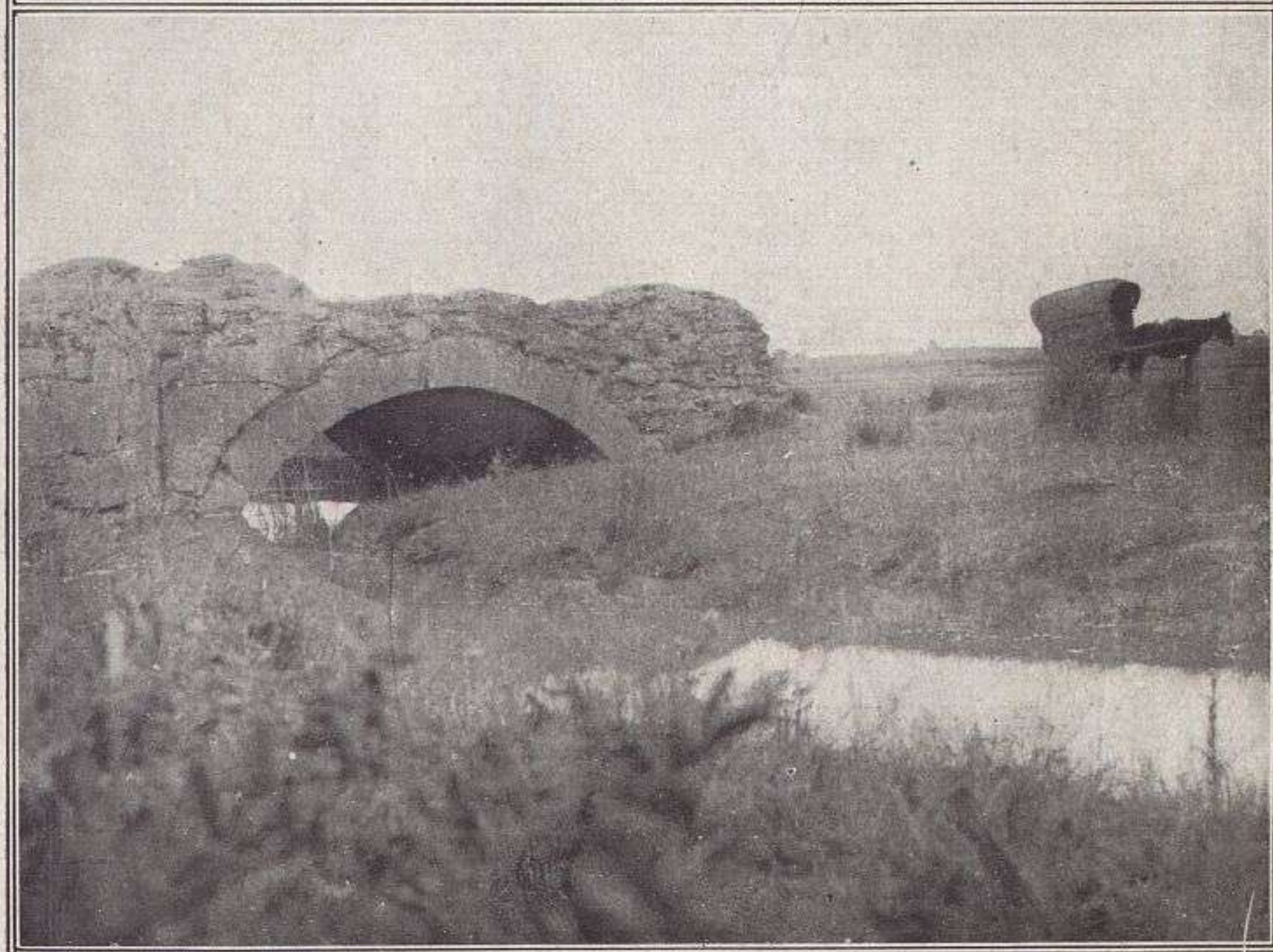
1. VÍA ROMANA CERCA DE SAHAGÚN. 2. PUENTE SOBRE EL VALDERA.
