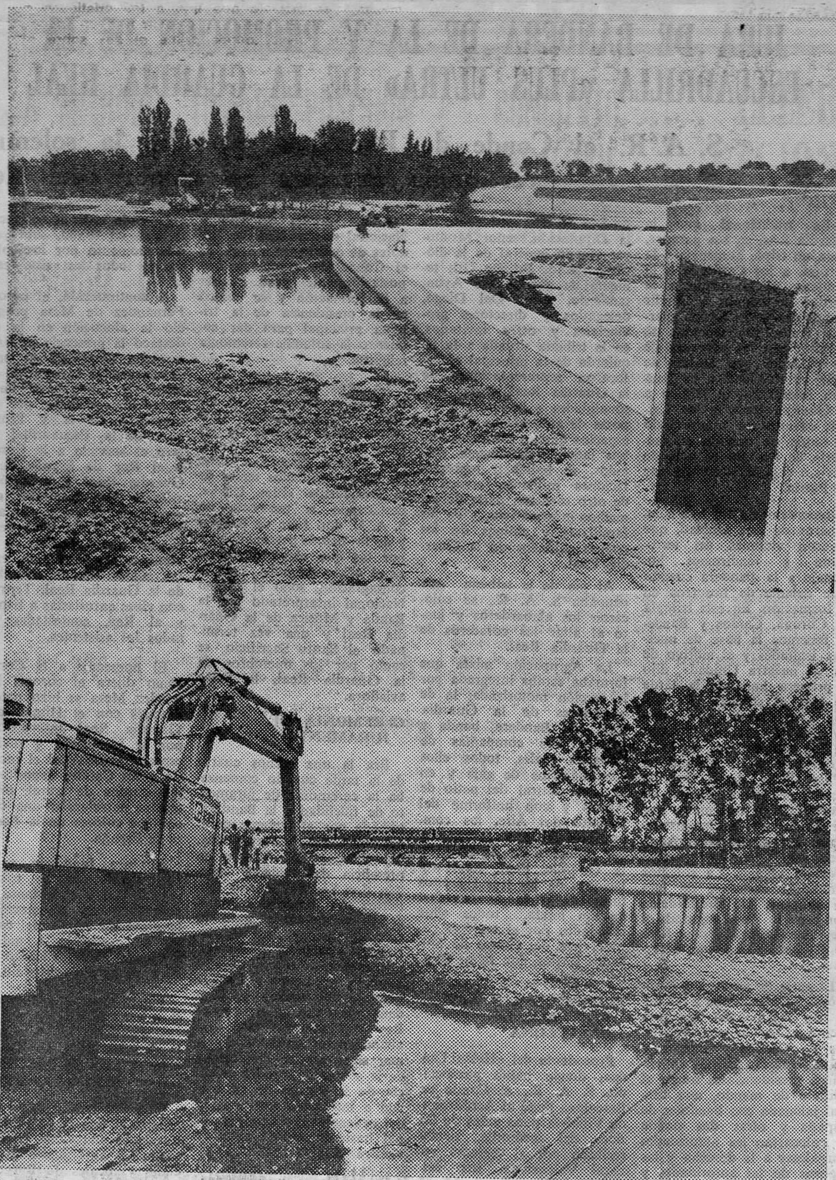
Las obras de la futura playa artificial que el Ayuntamiento está construyendo en la zona de Fuente del Prior avanzan y dentro de un mes, aproximadamente, tendrán ya la configuración física que se quiere dar a esa parte navegable del Arlanzón, junto al puente del Capiscol. Ya se ha construido la primera presa con los aliviaderos y se hace la segunda, en la otra margen del río. No podrá ser ya utilizada este verano, pero el próximo, la ciudad dispondrá de una pequeña playa artificial que constituirá una zona de portiva de indudable interés popular. — (Foto Villafranca).
