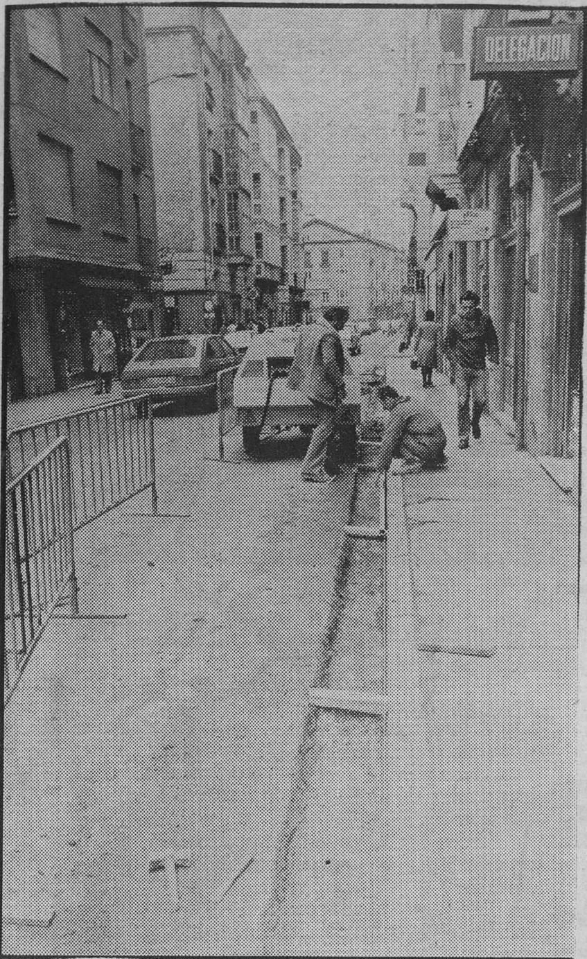
El vecindario de la calle de Laín Calvo conoce muy bien el calvario que ha padecido en tiempo de lluvias al anegarse los registros del alcantarillado de dicha vía pública que cuando fue repavimentada quedó cubierta en toda su superficie con la masa del asfalto fundido en caliente.
