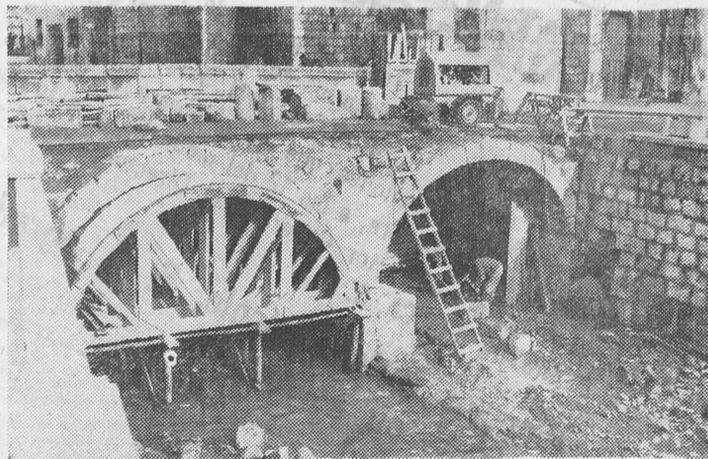
El puente de San Lesmes, doblemente centenario, está siendo sometido a consolidación y ensanchamiento. — (Foto FEDE.)
