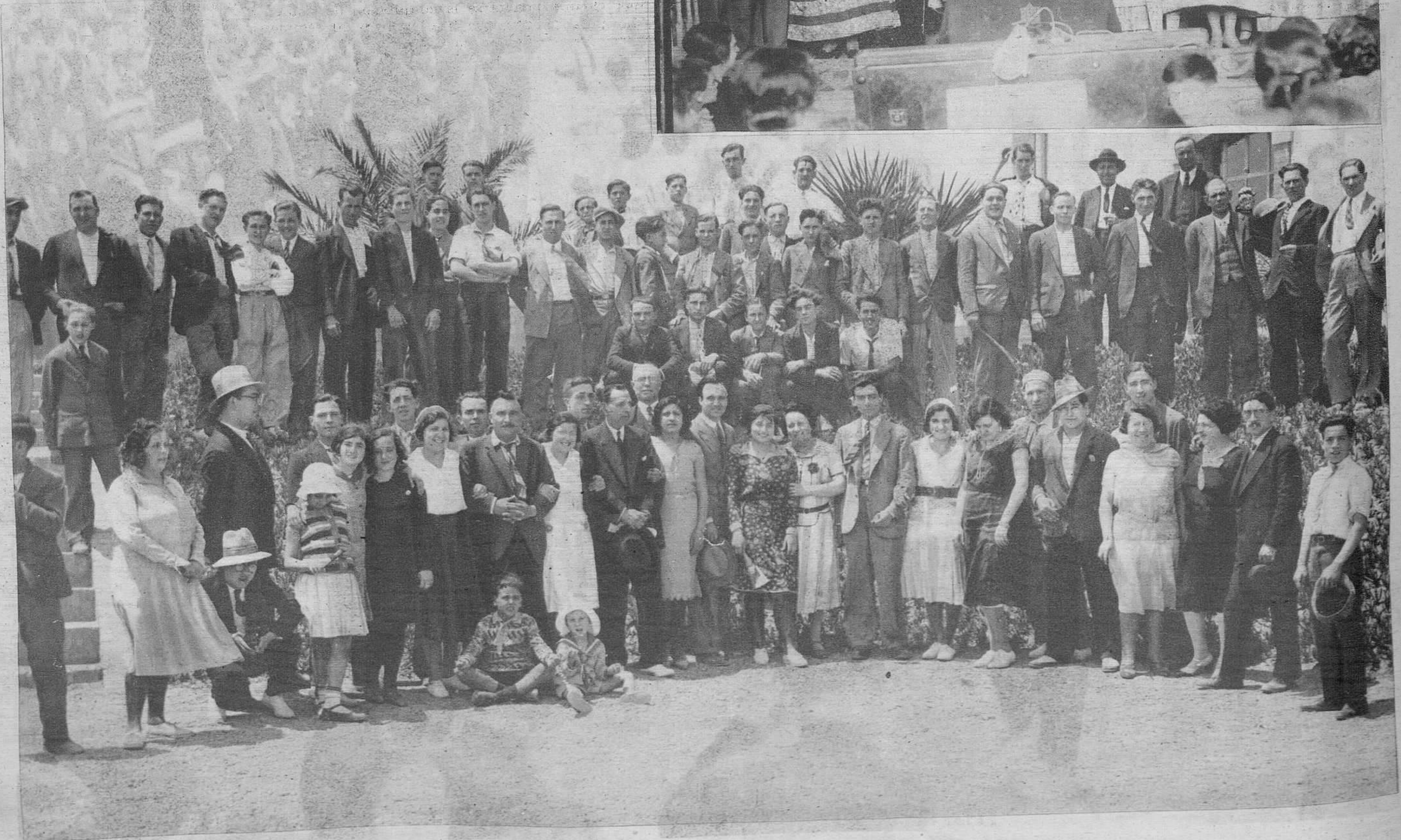
Los excursionistas de la «Escuela del Trabajo» de Valls, que visitaron la instalación de La Presa de Aguas Potables. (Foto Lázaro)
