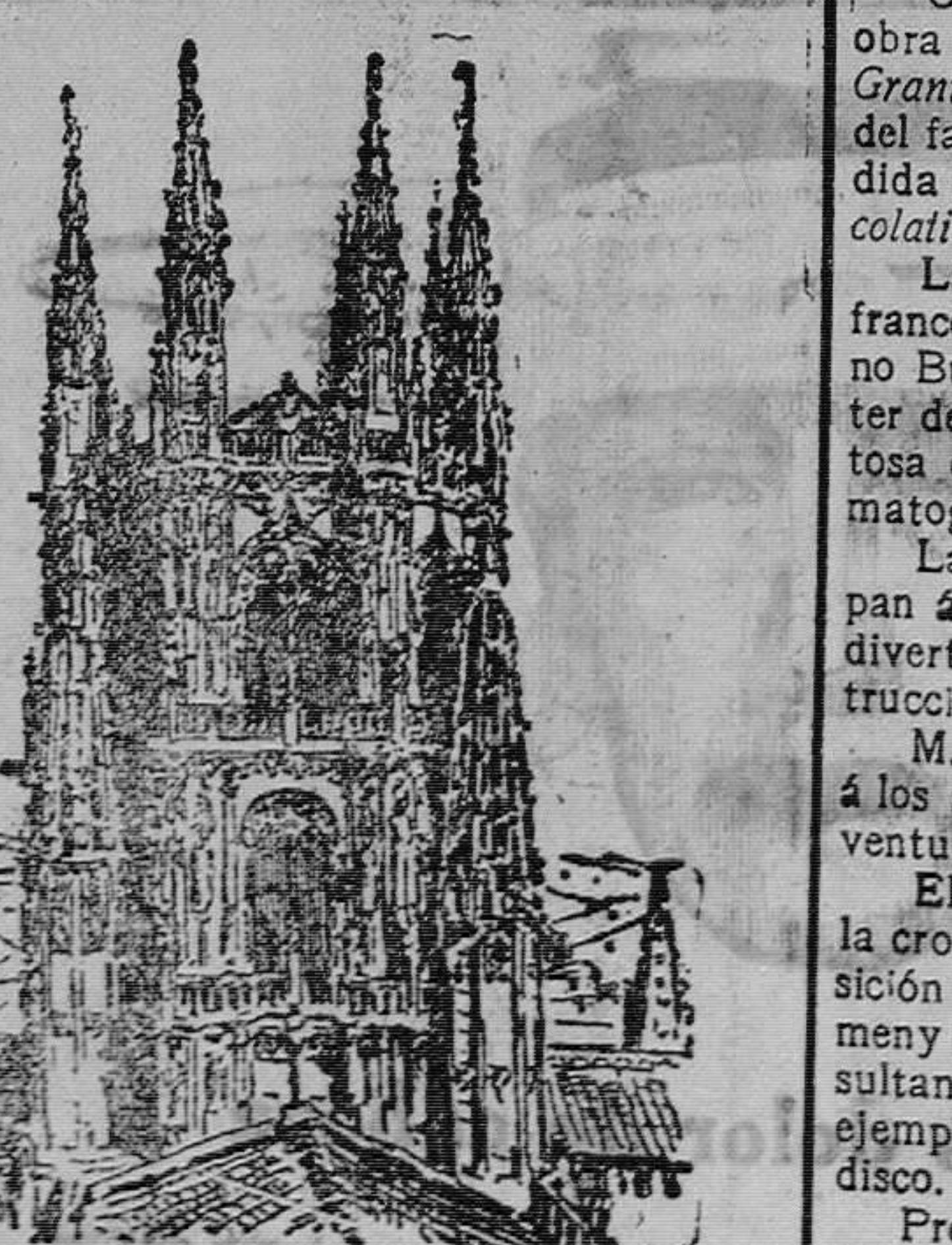
Una de las partes de la Catedral de Burgos que exige las más prontas reparaciones, por su estado de ruina.
