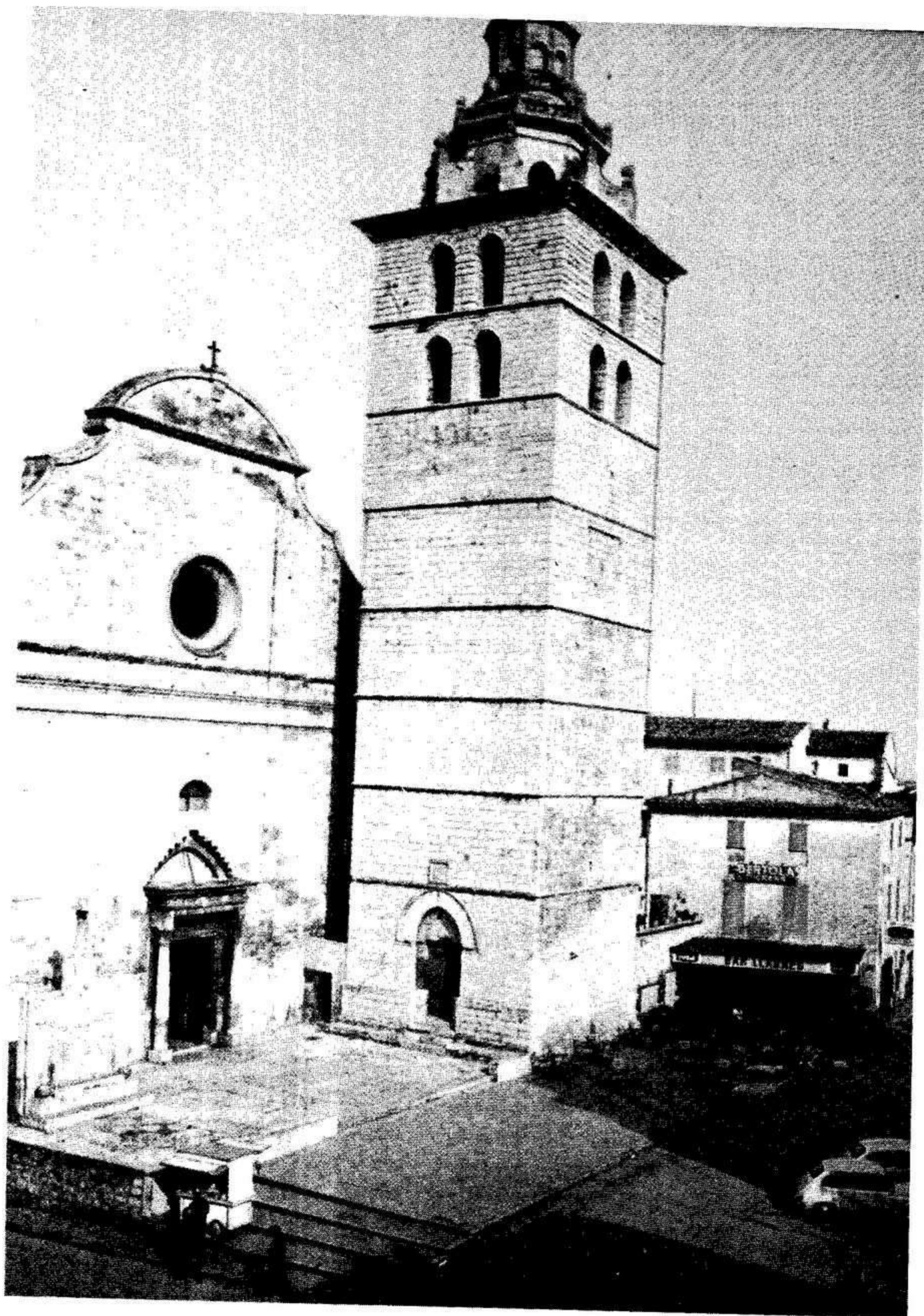
Façana i torre de l'església de Santa Maria d'Inca.
