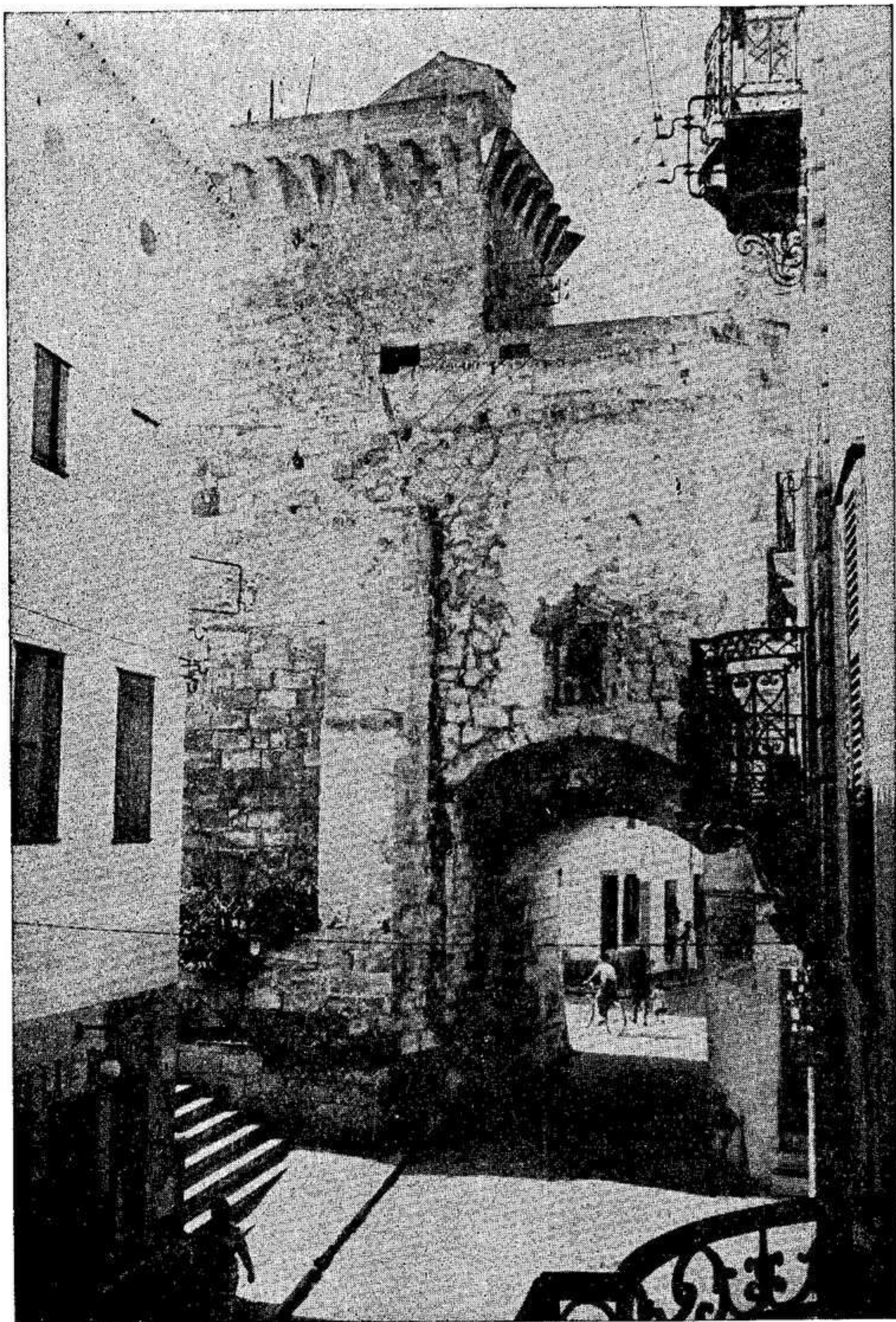
PUENTE DE SAN ROQUE (MAHÓN)
