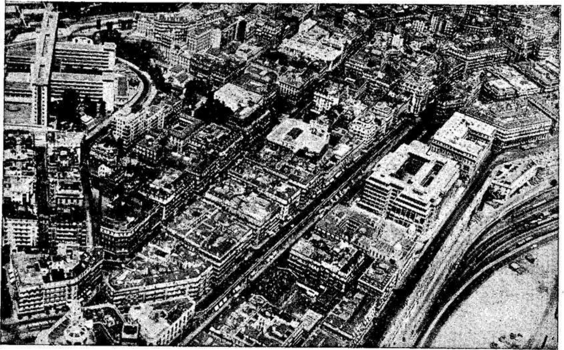
VISTA AÉREA DEL BARRIO COMERCIAL DE ARGEL
