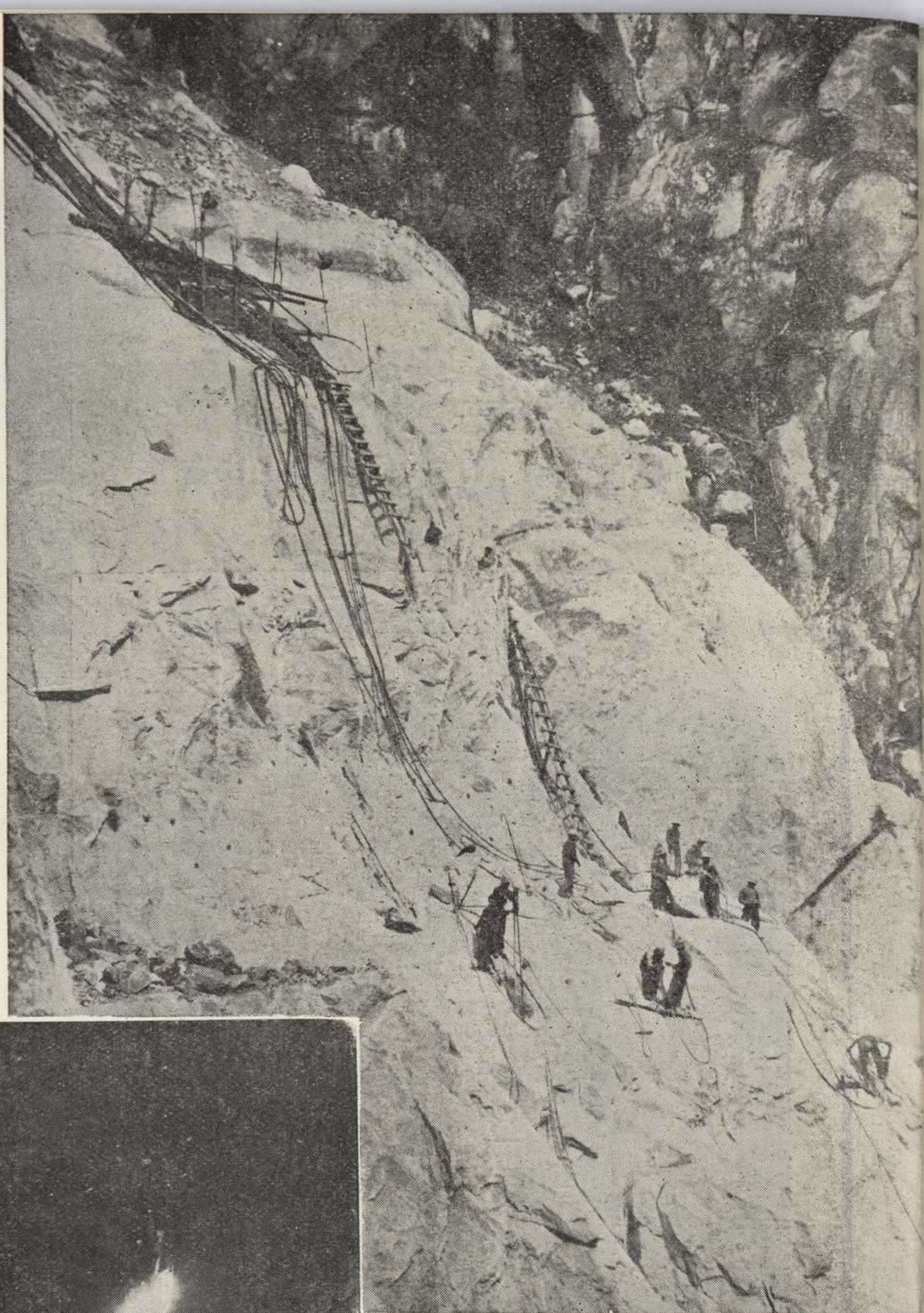
También en esta foto que nos muestra la destroza destinada a alojar el Cuerpo superior de la futura Central, se aprecian sus gigantescas dimensiones. En esta nave excavada en la roca se alojarán en su día los 6 grupos de que constará esta Central de Aldeadávila, con una potencia de 762.000 KVA y una producción anual de 1.700 millones de KWh. de energía regulada.
