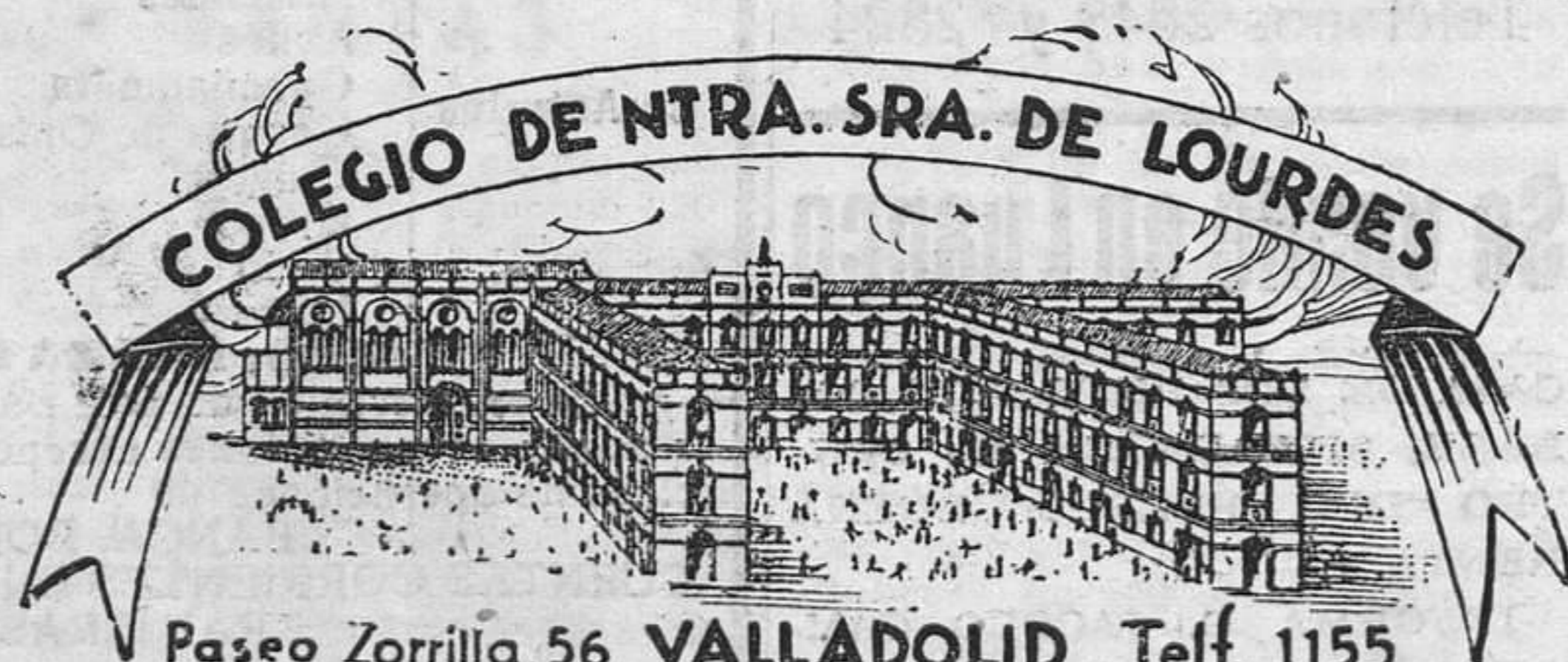
Paseo Zorrilla, 56 VALLADOLID Telf. 1155
