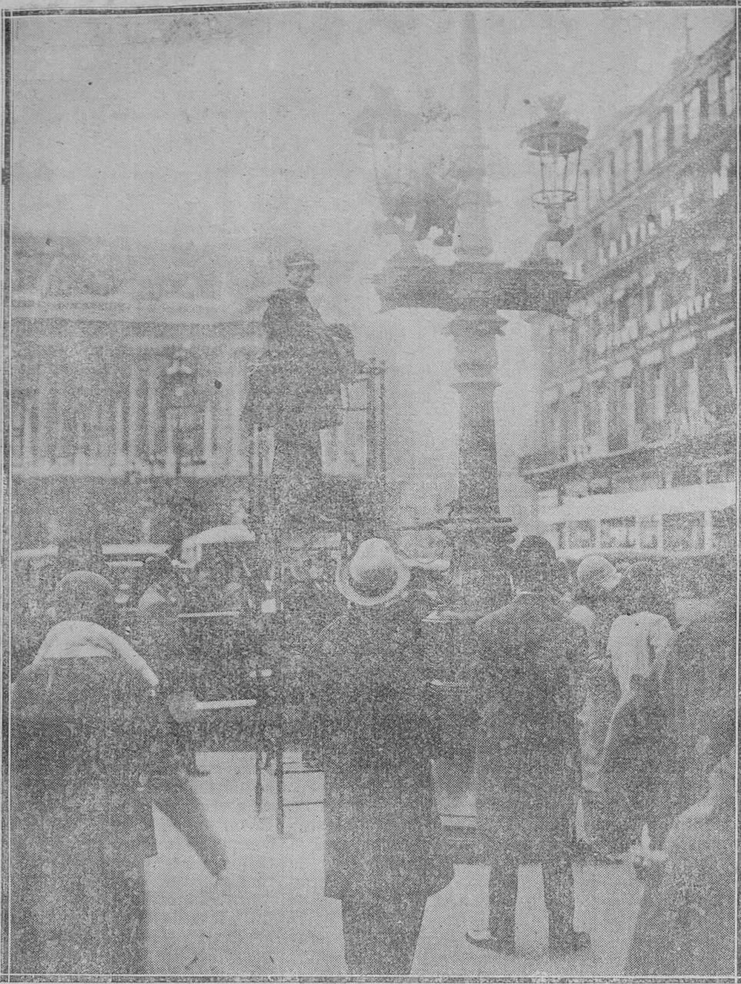
Un puesto de Vigilancia en la Plaza de la Opera instalado para reglamentar la circulación de los vehículos. (Foto Vidal).
