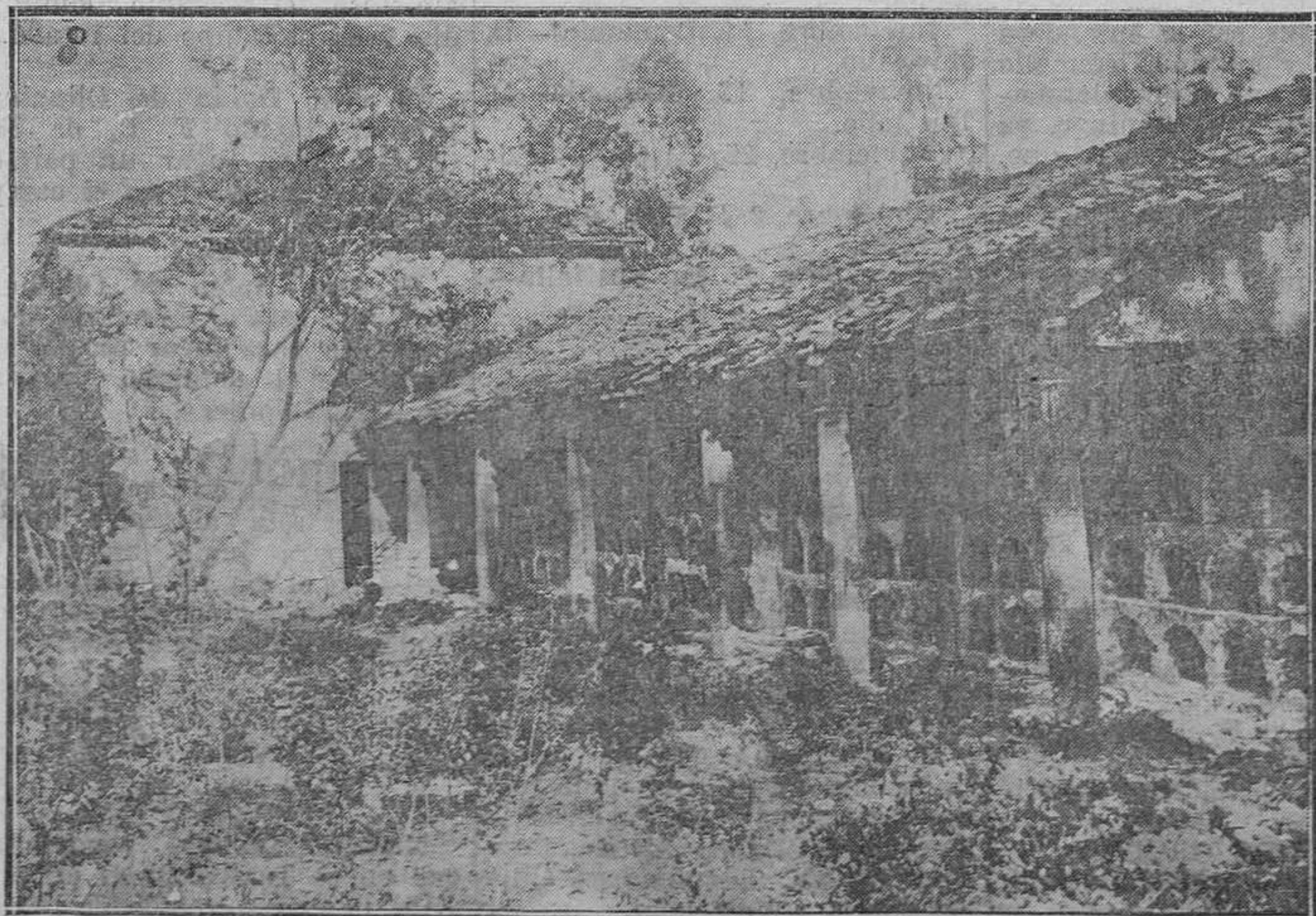
OVIEDO.—El Cementerio Viejo.— Un detalle de las galerías.
