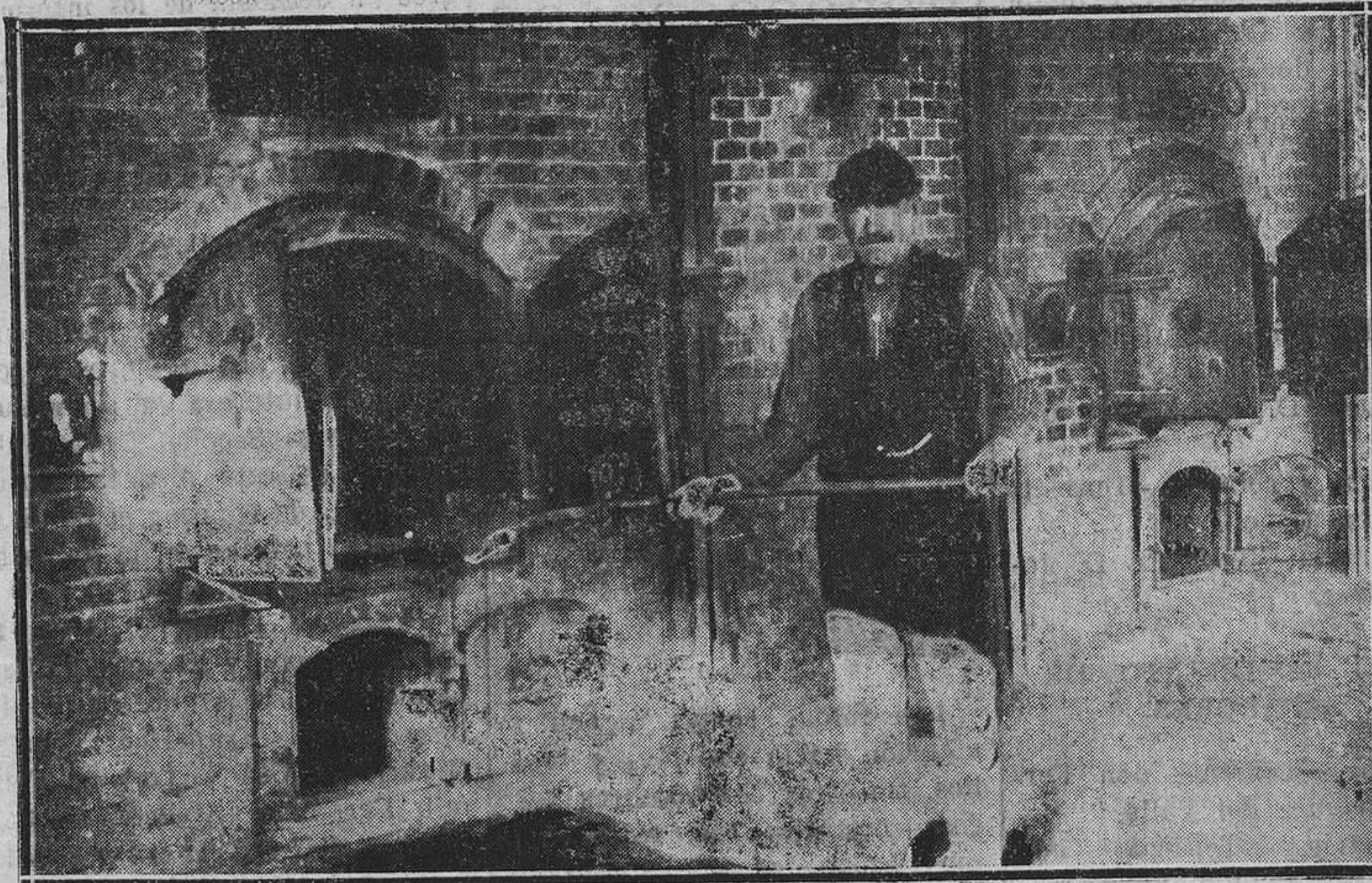
Las bocas de los hornos, en los que arden la leña y el carbón, que reducen prontamente a cenizas las basuras.
