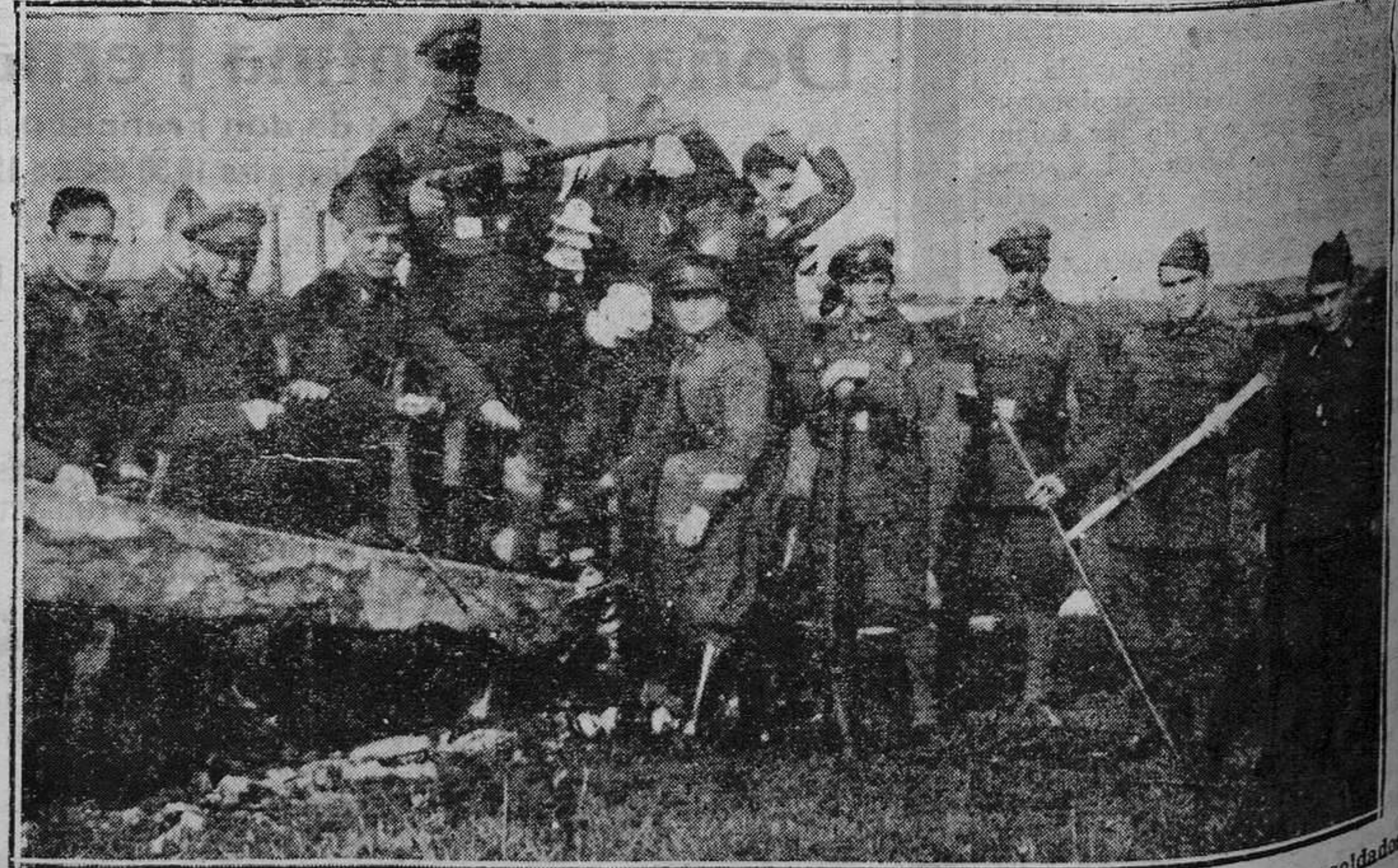
GIJON.—Poste derribado con dinamita por los huelguistas en el barrio de Pumarín. Los soldados de Ingenieros arreglando la avería. (Foto Suárez).
