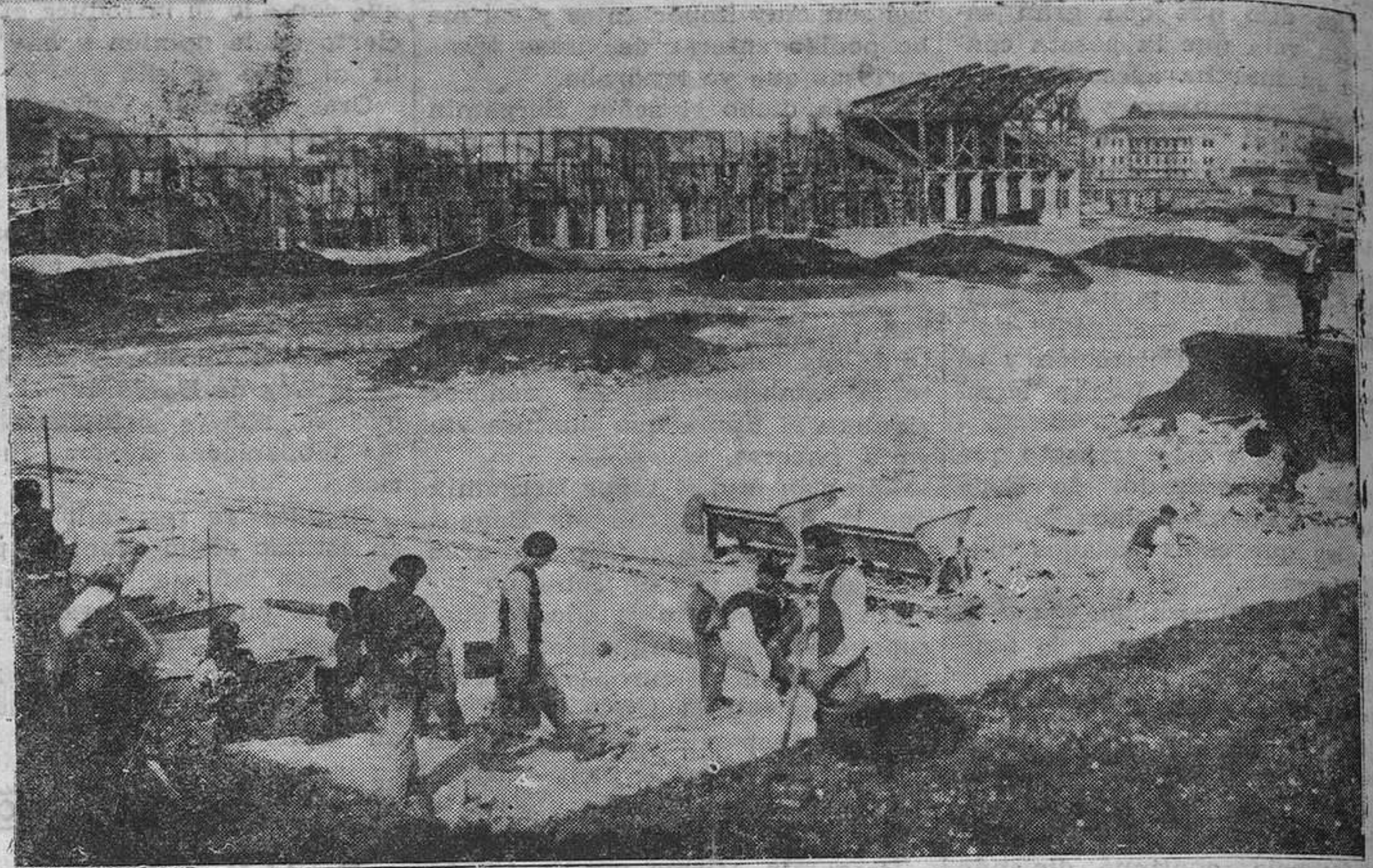
La perspectiva actual de las obras—revoltijo de instrumental, vagonetas, tierras y hierros—va delineando la conformación del Stadium.
