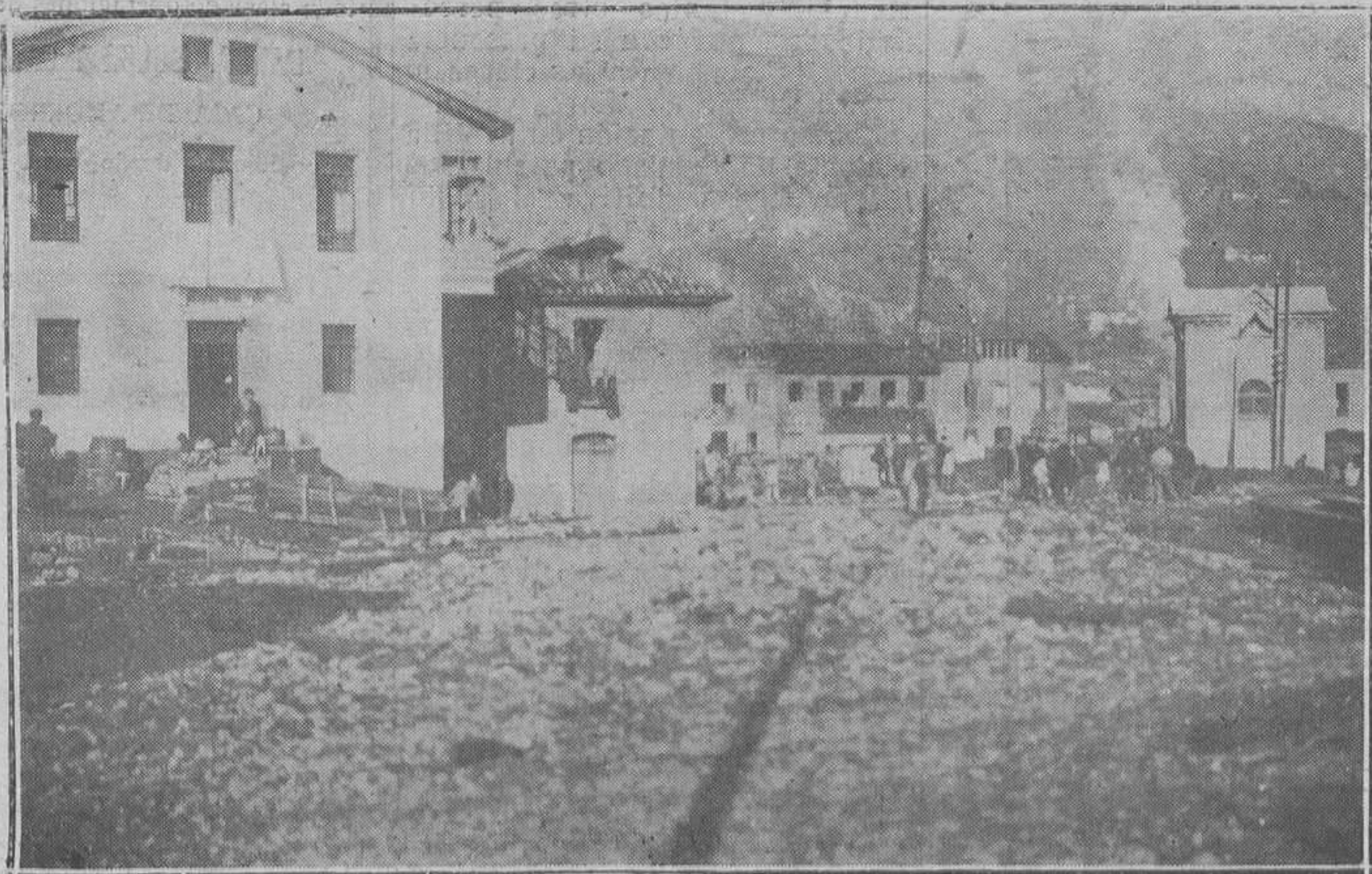
SANTA ANA (LANGREDO). Un barrio completamente inundado por el río Villar.
