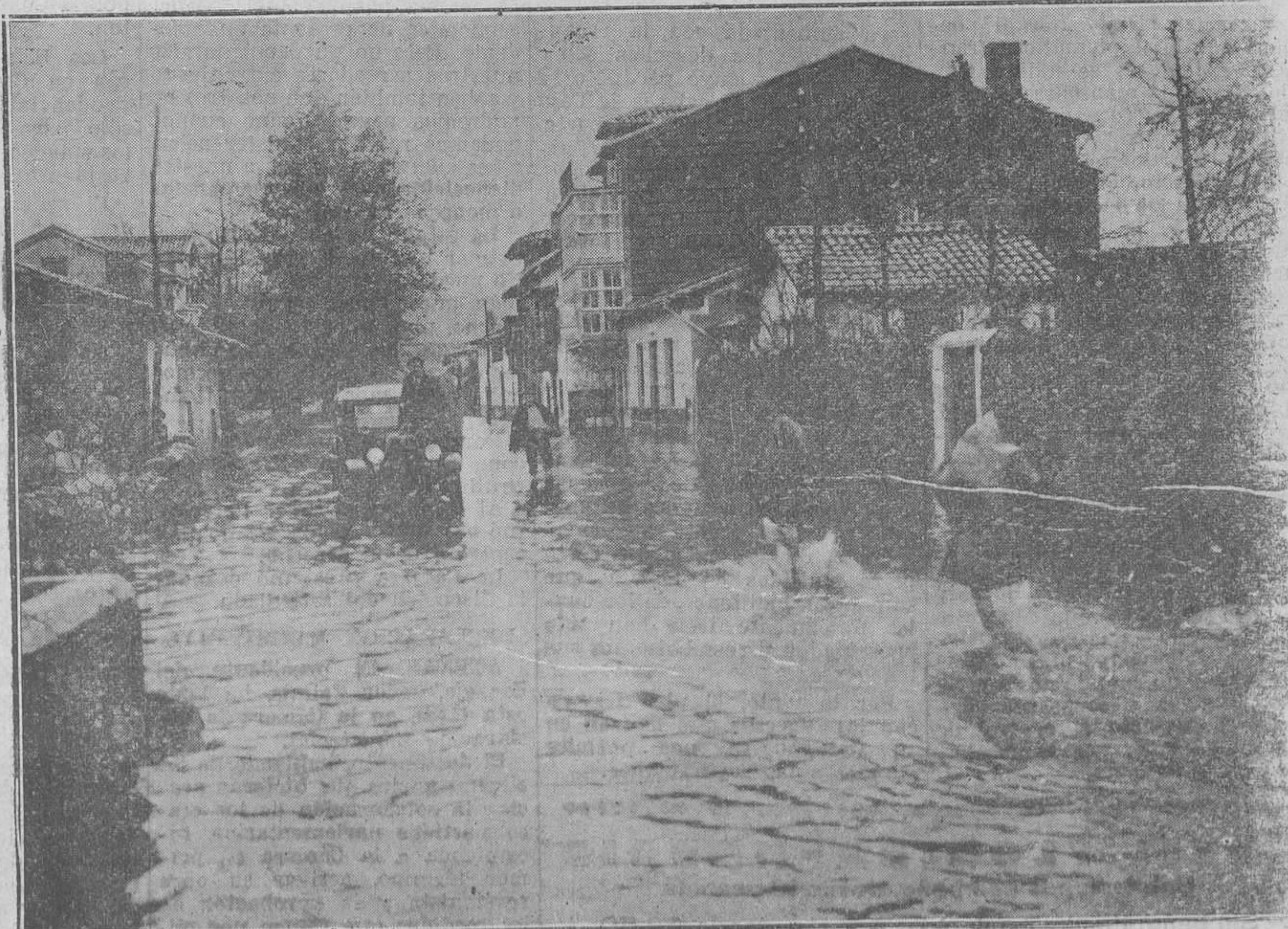
SANTANDER.-La carretera de Asturias, inundada por el río Pas, en Puente-Arco.
