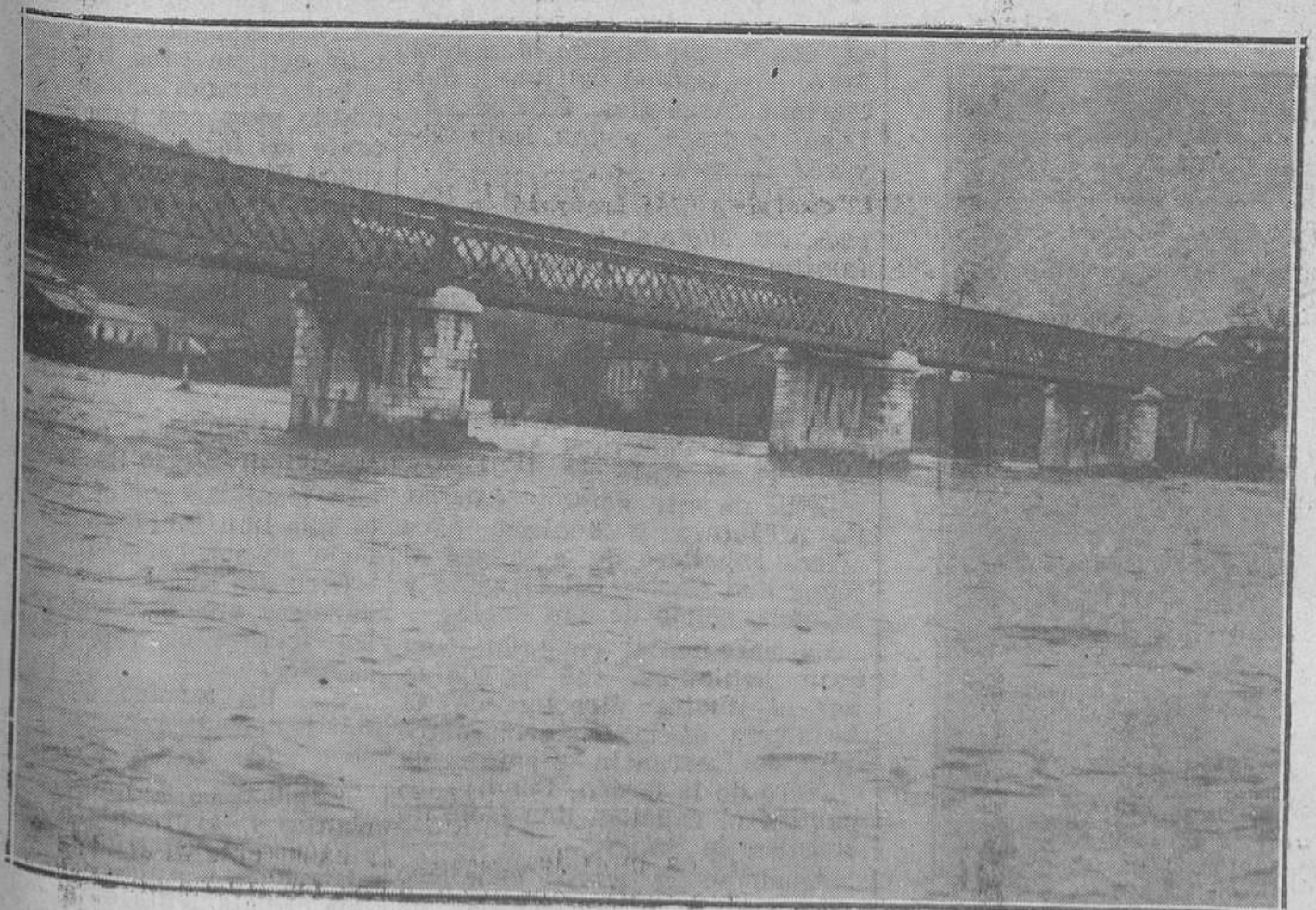
TRUBIA: LOS ULTIMOS TEMPORALES.—Imponente aspecto del Nalón en las inmediaciones del vertedero (Foto Mena)
