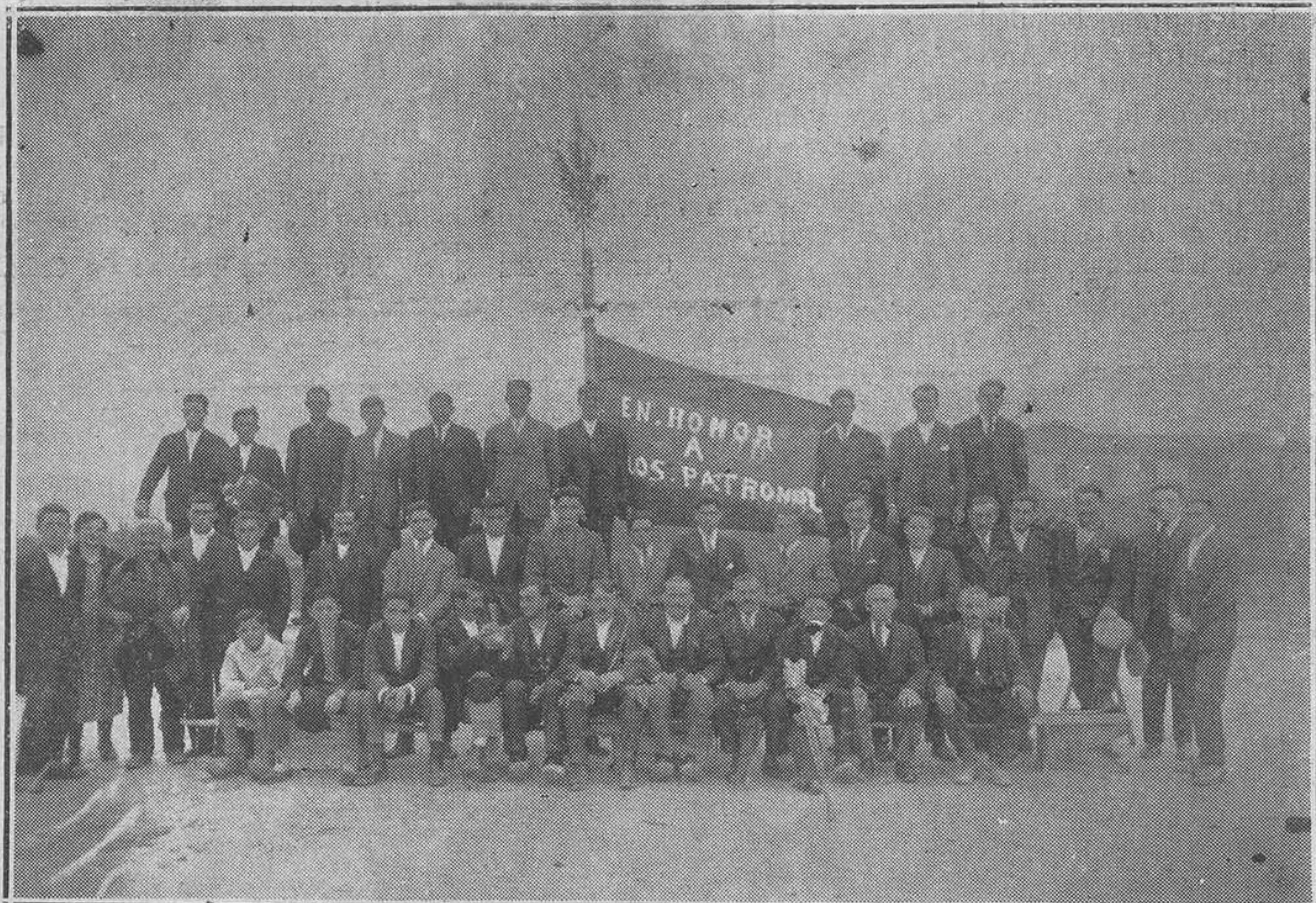
Grupo de obreros momentos después de colocar el ramo en el nuevo Depósito de aguas del Fresno. (Foto Pardo)
