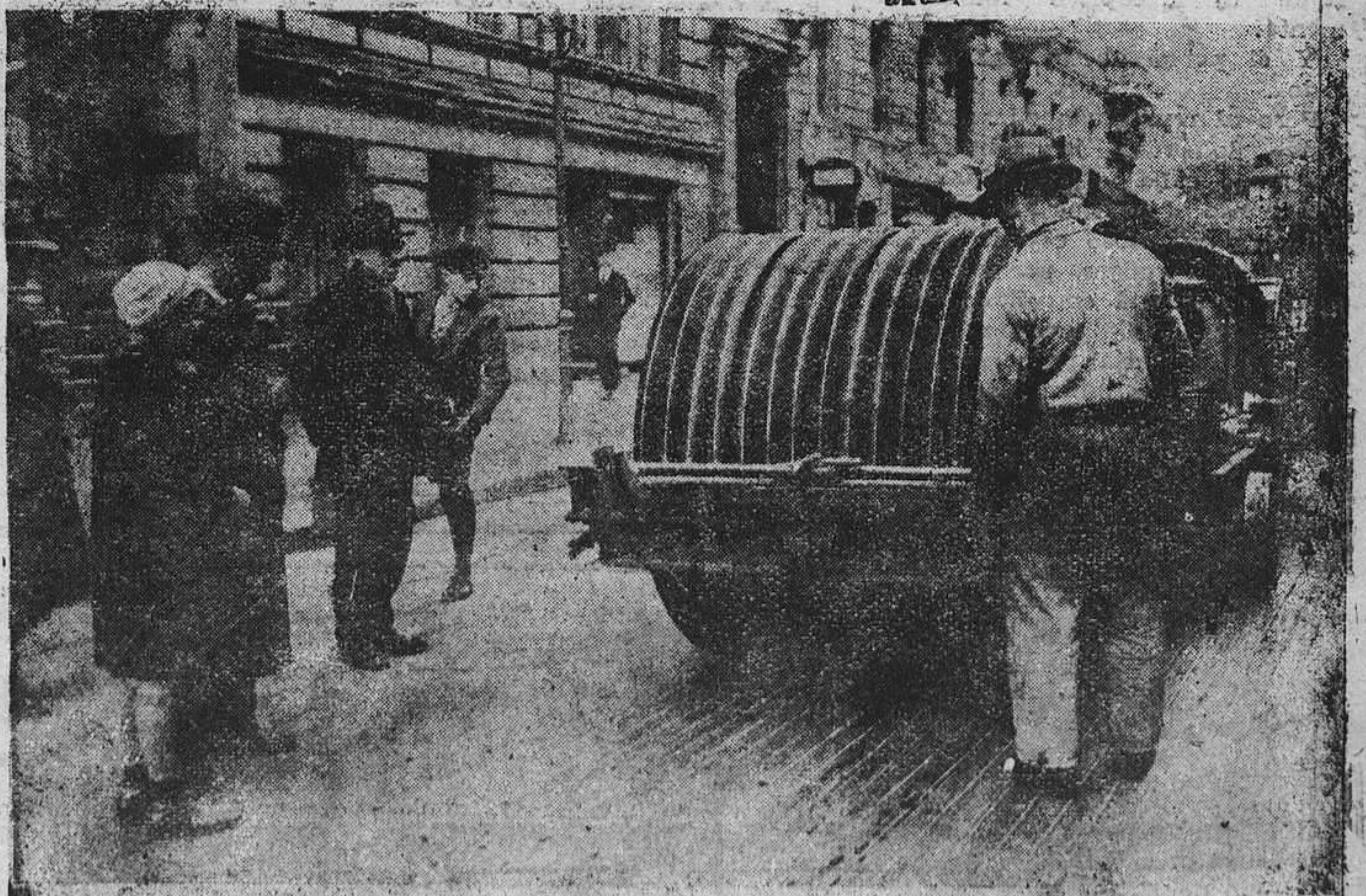
BERLIN.—Operación realizada sobre el asfalto de las calles de esta capital para evitar que patinen los "autos" sobre el pavimento mojado.
