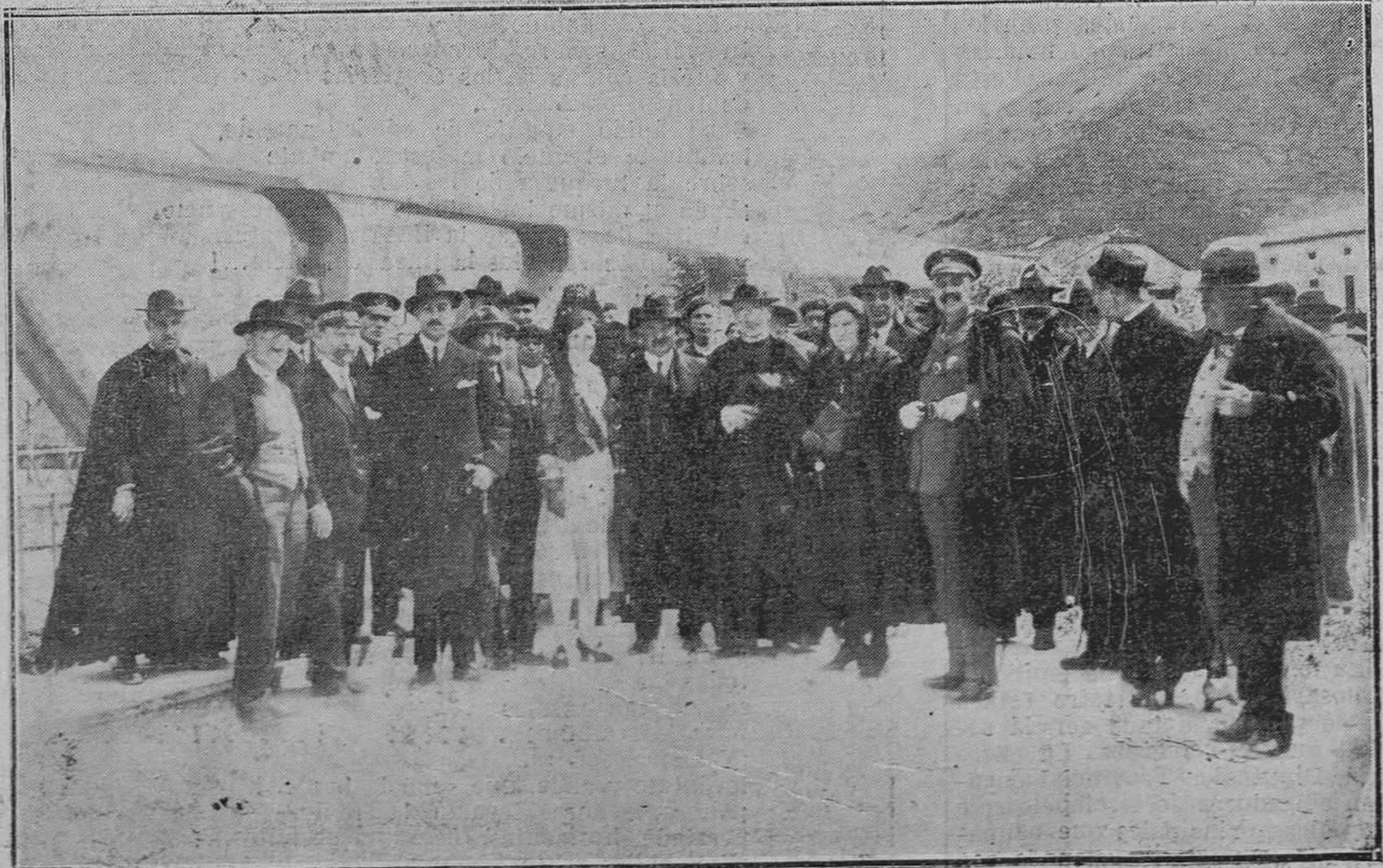
ENQUERA-BUSTIO.-Las autoridades santanderinas y asturianas, entre las que figura el gobernador señor Fuentes Pila, en la inauguración del puente que une las dos provincias.
