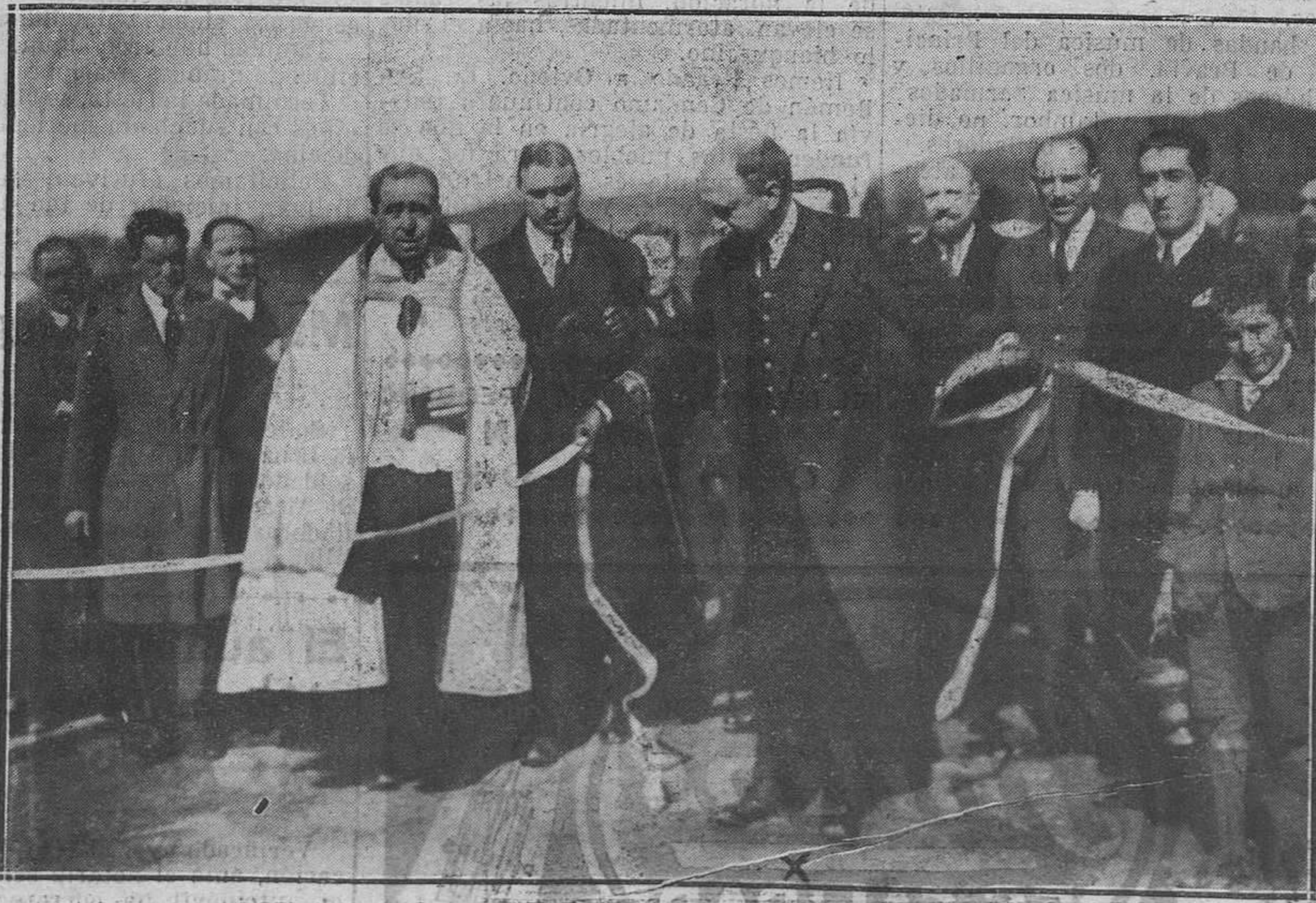
INAUGURACIÓN DEL PUENTE DE SAN ROMÁN DE CANDAMO.—El ingeniero jefe de Obras Públicas de la provincia, D. José Rodríguez Ribera (x), en el momento de romper las cintas para dar paso, después de la bendición. (Foto Buelta)
