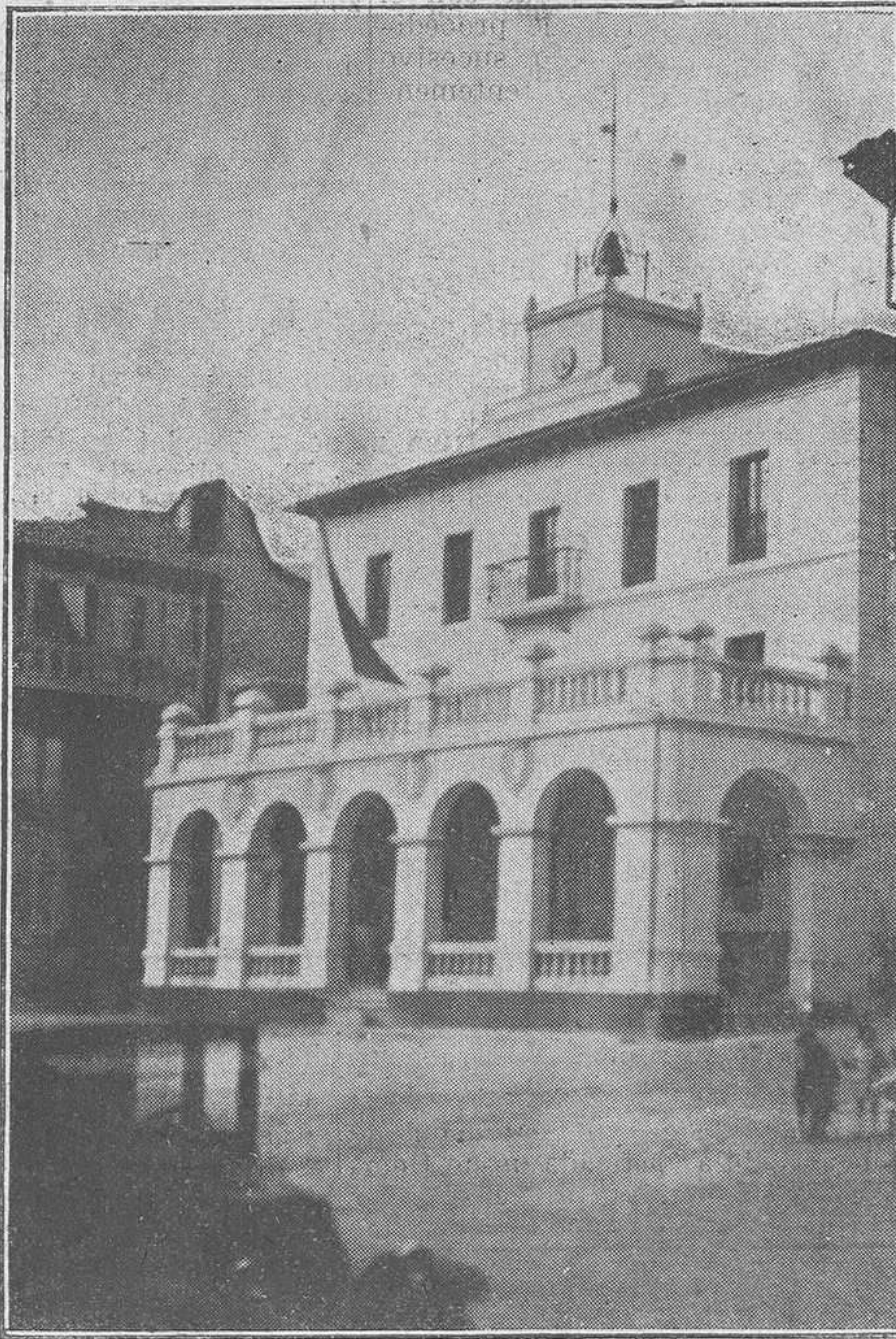
TINEO.—Edificio del Ayuntamiento después de las grandes reformas llevadas a cabo, que han merecido el agradecimiento del vecindario para nuestra Corporación, que preside don Benito de la Torre. Su interior ha sido completado con un serio y artístico mobiliario de la Casa Viena, de Oviedo, sobresaliendo el magnífico salón de sesiones, de verdadero gusto artístico.
