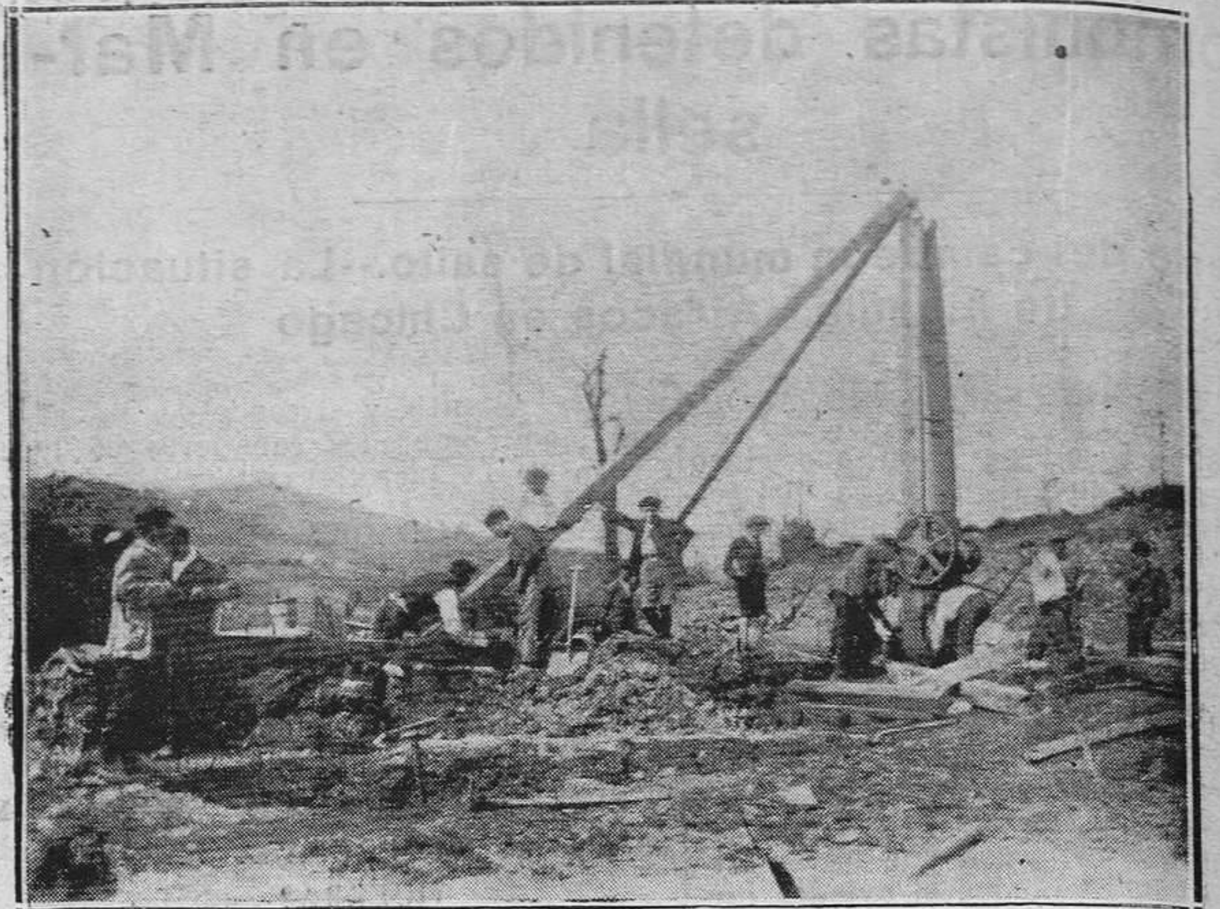
LA FELGUERA.—Estado actual de las obras para la traída de aguas.
