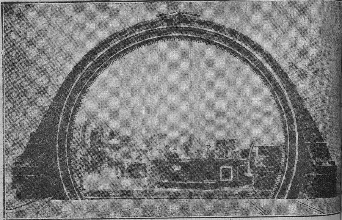
Parte fija de un gran alternador, volante de 5.800 kva. de 10 metros y medio de diámetro.
