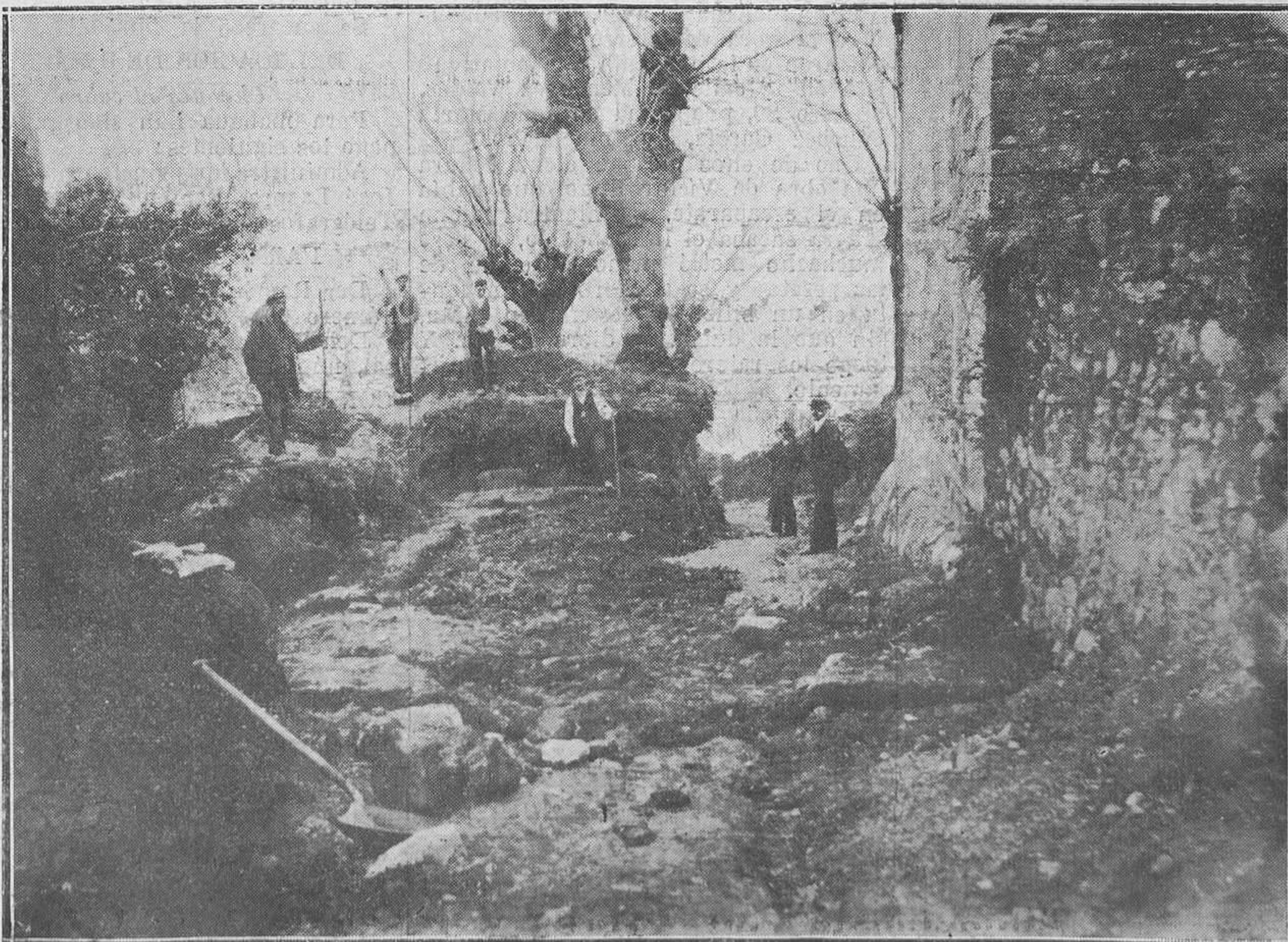
Fig. B.-Practicando excavaciones detrás del templo de San Miguel de Lillo.
