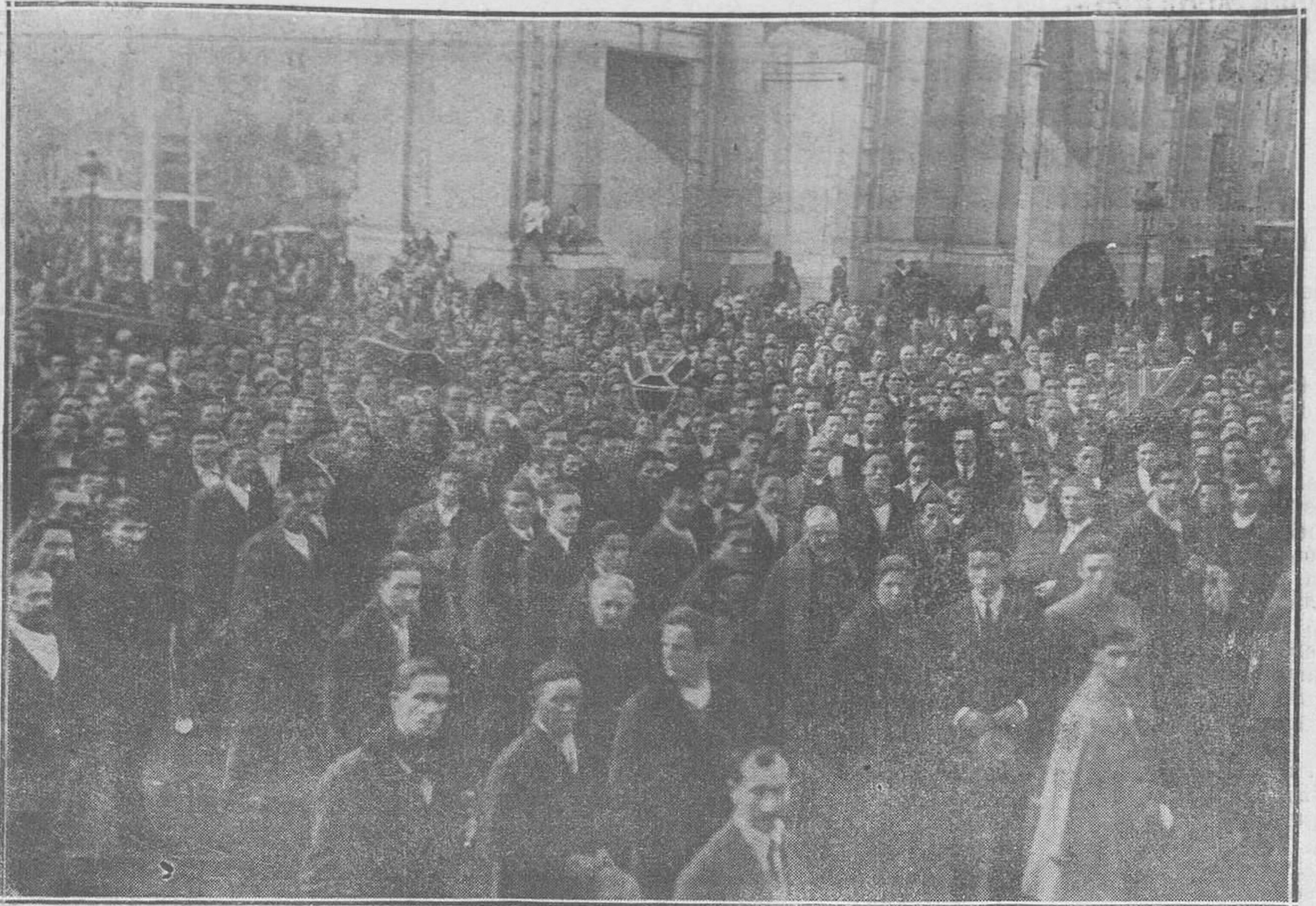
MADRID: Imponente manifestación de duelo, por el entierro de los ocho obreros que perecieron en el hundimiento del pabellón de la perfumería "Floralia". (Foto Vidal)
