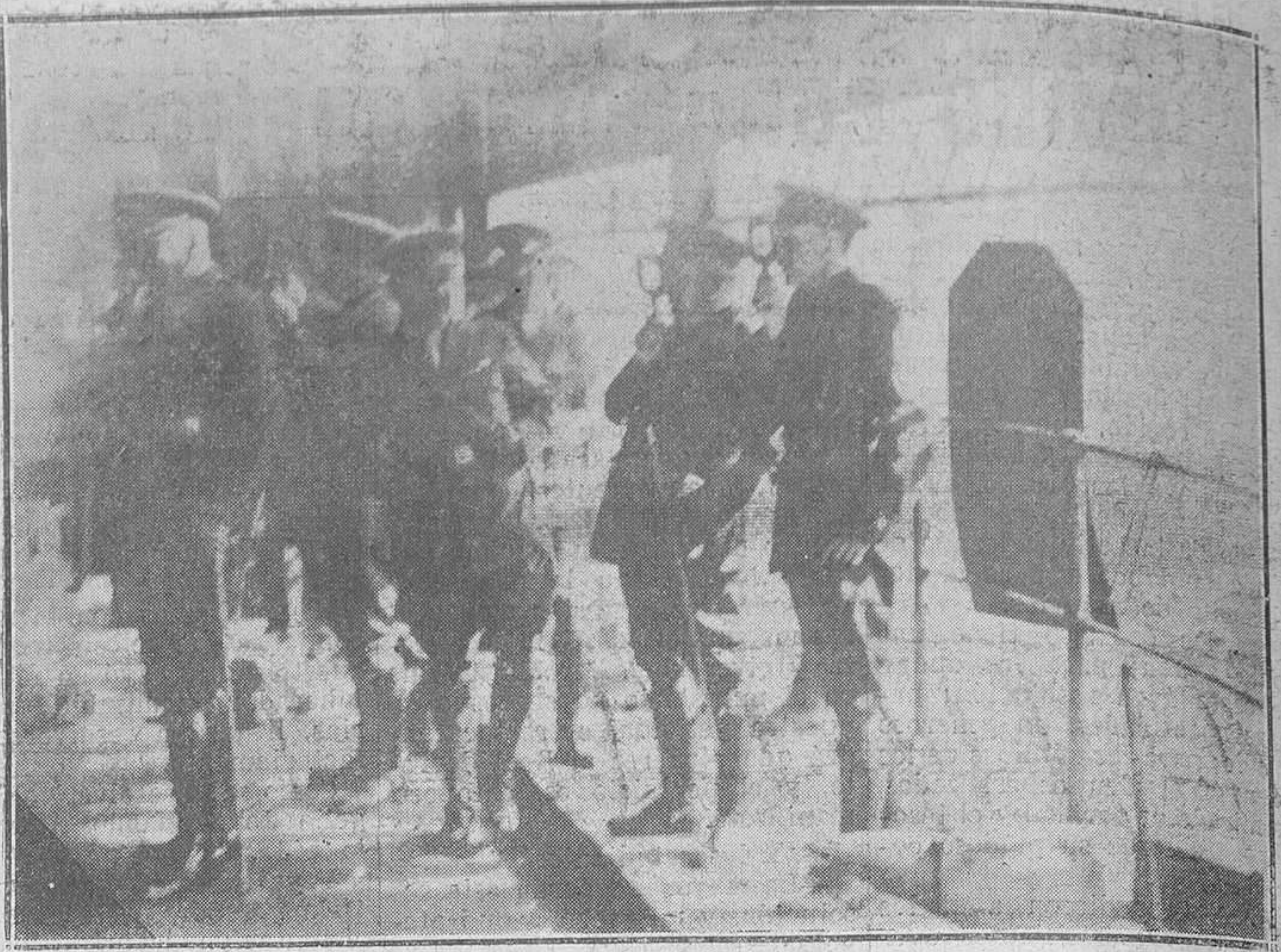
TRUBIA.-El capitán general y sus acompañantes, presenciando una Colada en la Fábrica de Cañones. (Foto Mena)
