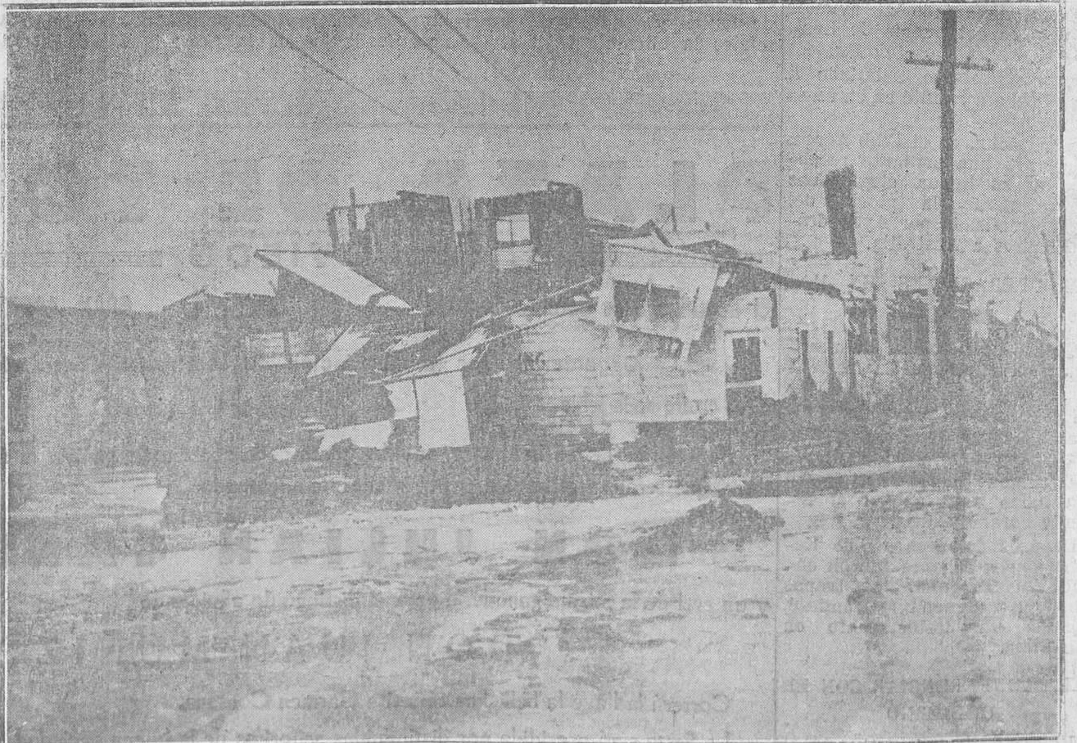
MIAMI (FLORIDA). -Aspecto de uno de los barrios de la ciudad, completamente destruido.
