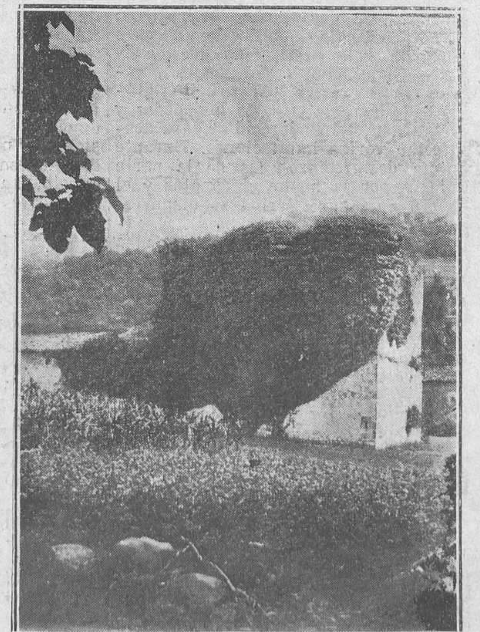
Torre de Bonia (desaparecida).
