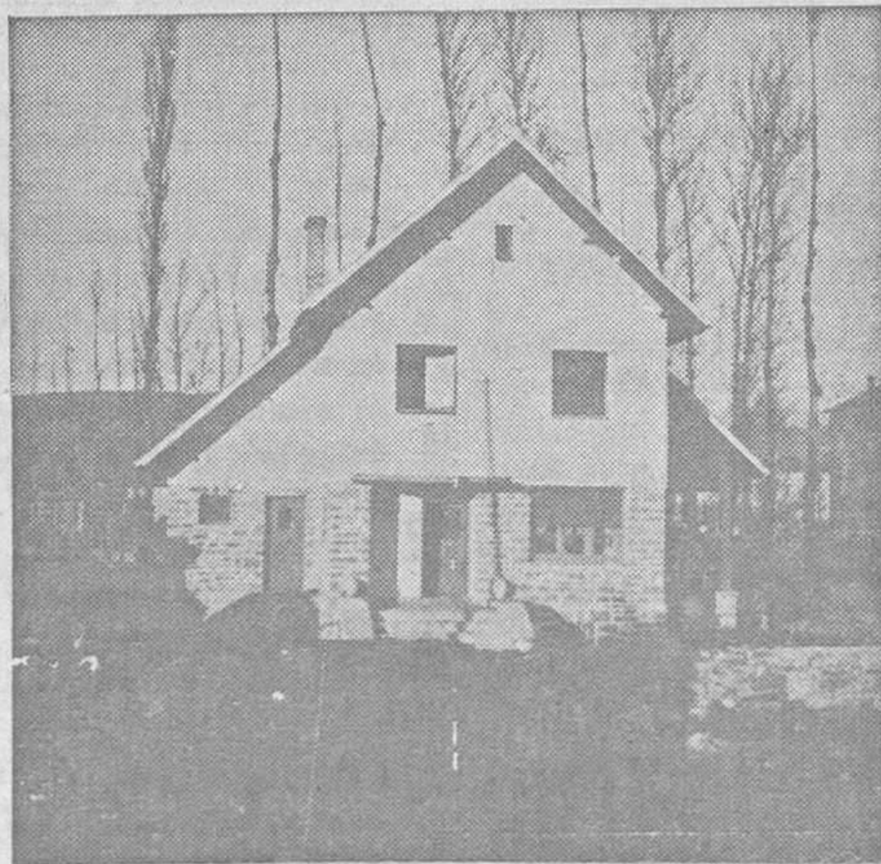
GUARDO (Palencia) - Bonito chalet propiedad de don José Antonio Fernández, recientemente construido y que ha sido completado con un confortable amueblado de la CASA VIENA, de Oviedo
