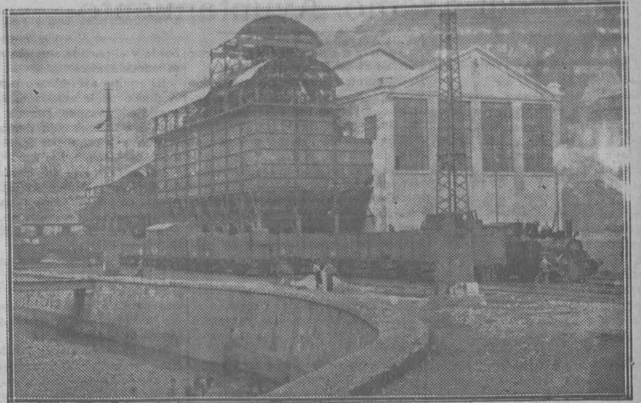
Actualmente el lavadero de «Hulleras del Turón» puede sin esfuerzo lavar seis mil toneladas de carbón diarias
