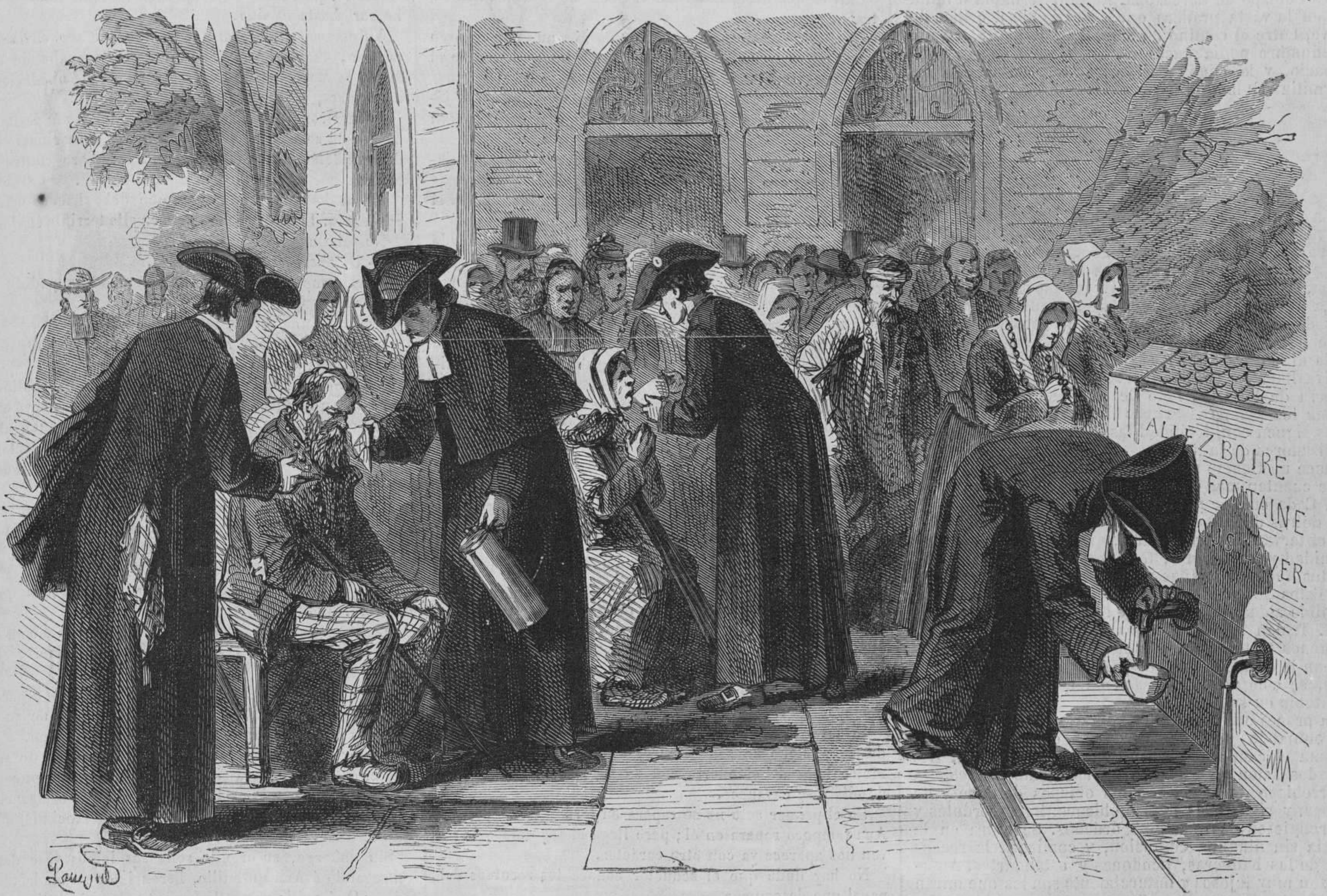
ROMERÍA DE LOURDES — Hermanos de la Doctrina Cristiana lavando á los impedidos con el agua milagrosa.
