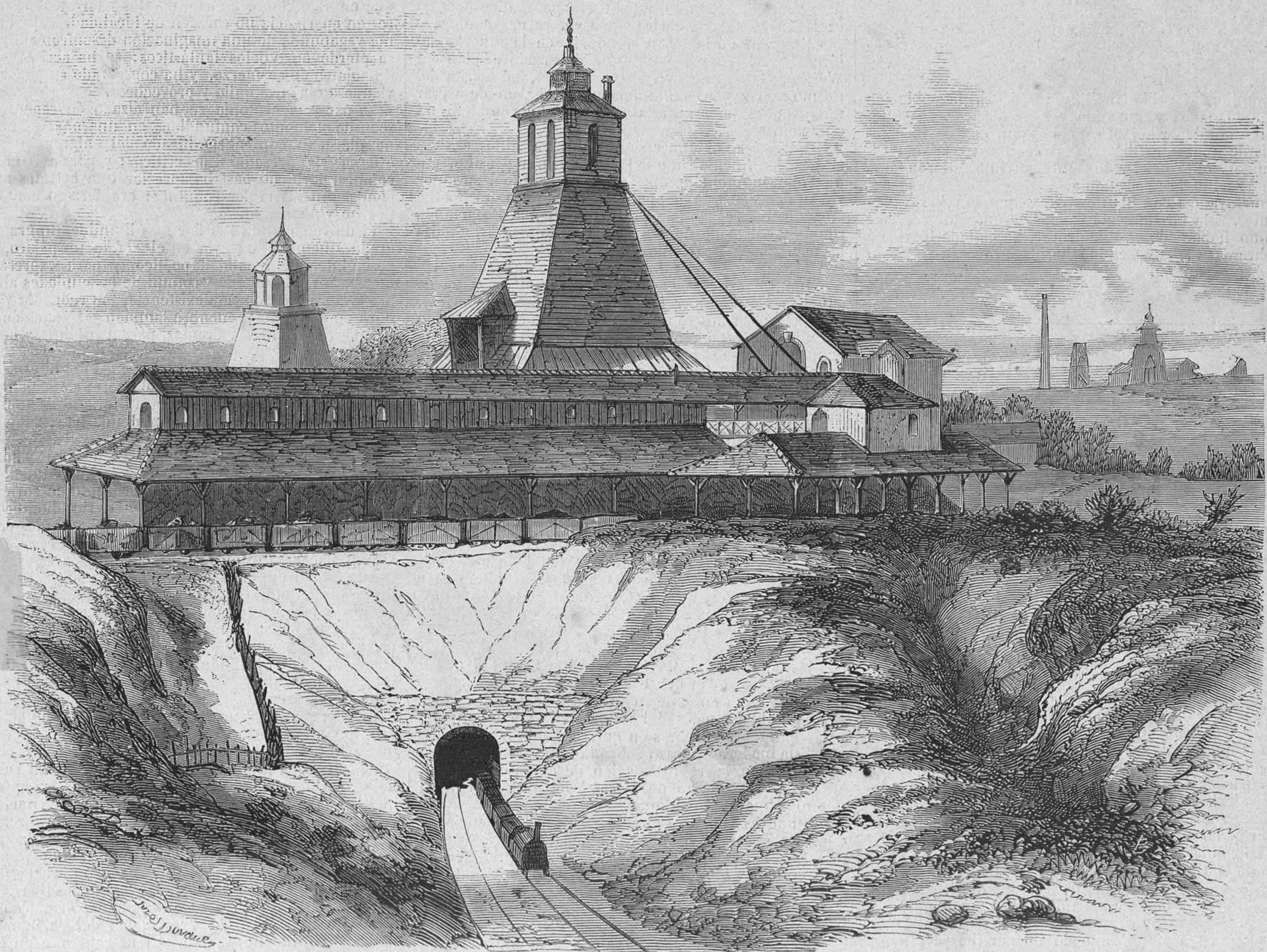
CATASTROFE DE LAS MINAS DE BLANZY. — Vista general del pozo llamado de Cinq-Sous.
