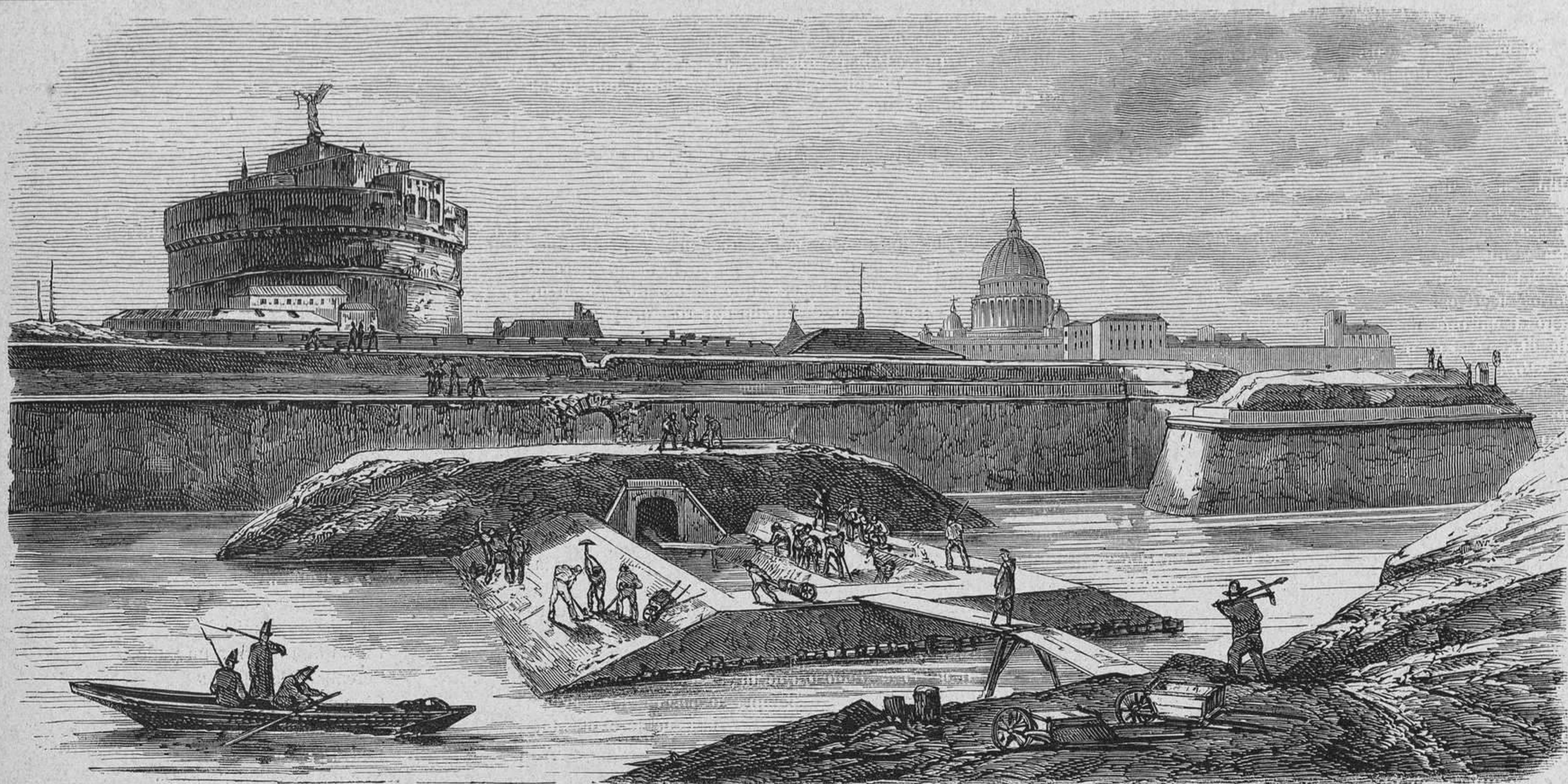
ROMA. — Obras de fortificación para la protección del paso subterráneo que conduce del Vaticano al fuerte del Santo Angel.
