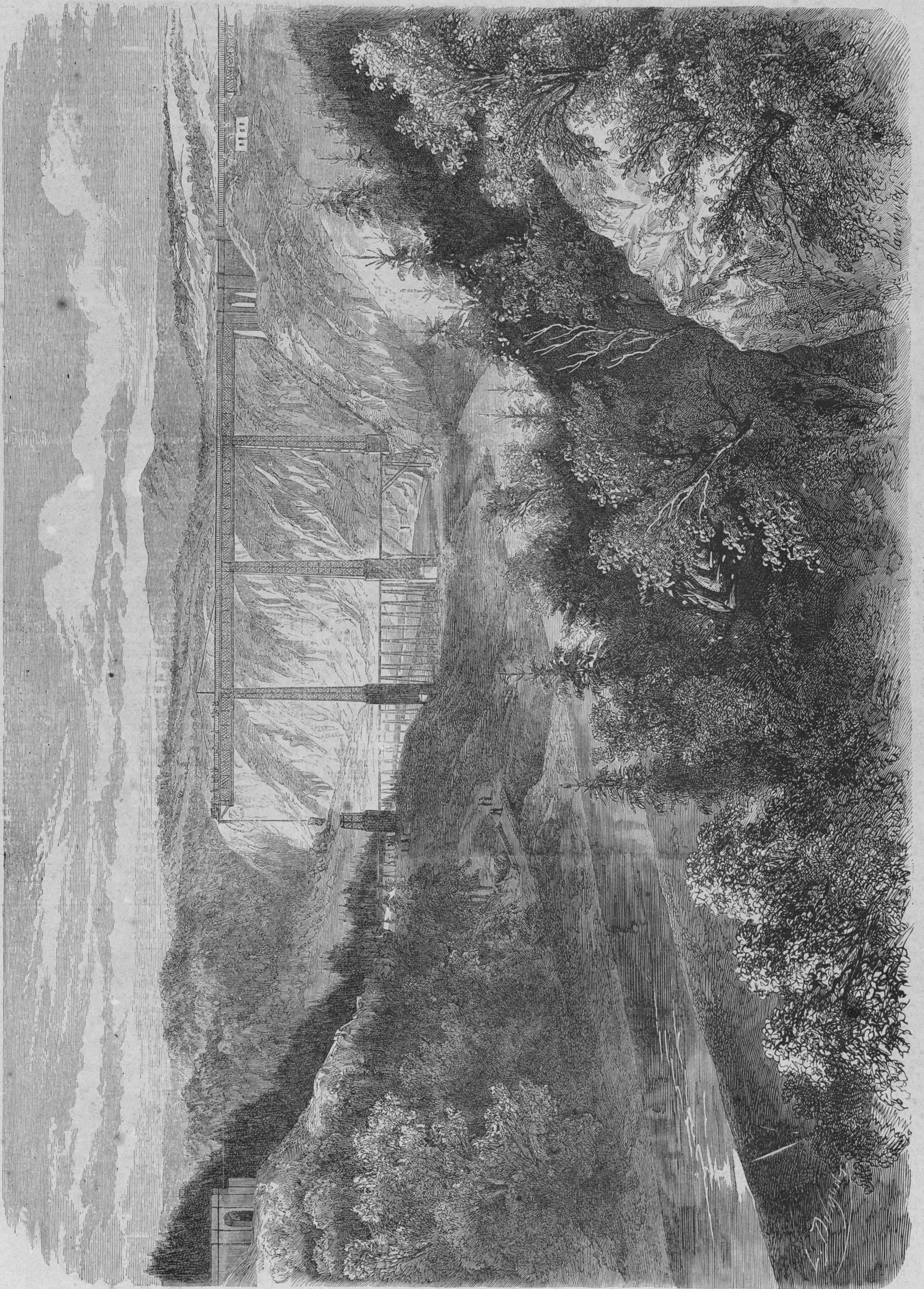
Viaducto del Sarina en Friburgo (Suiza).
