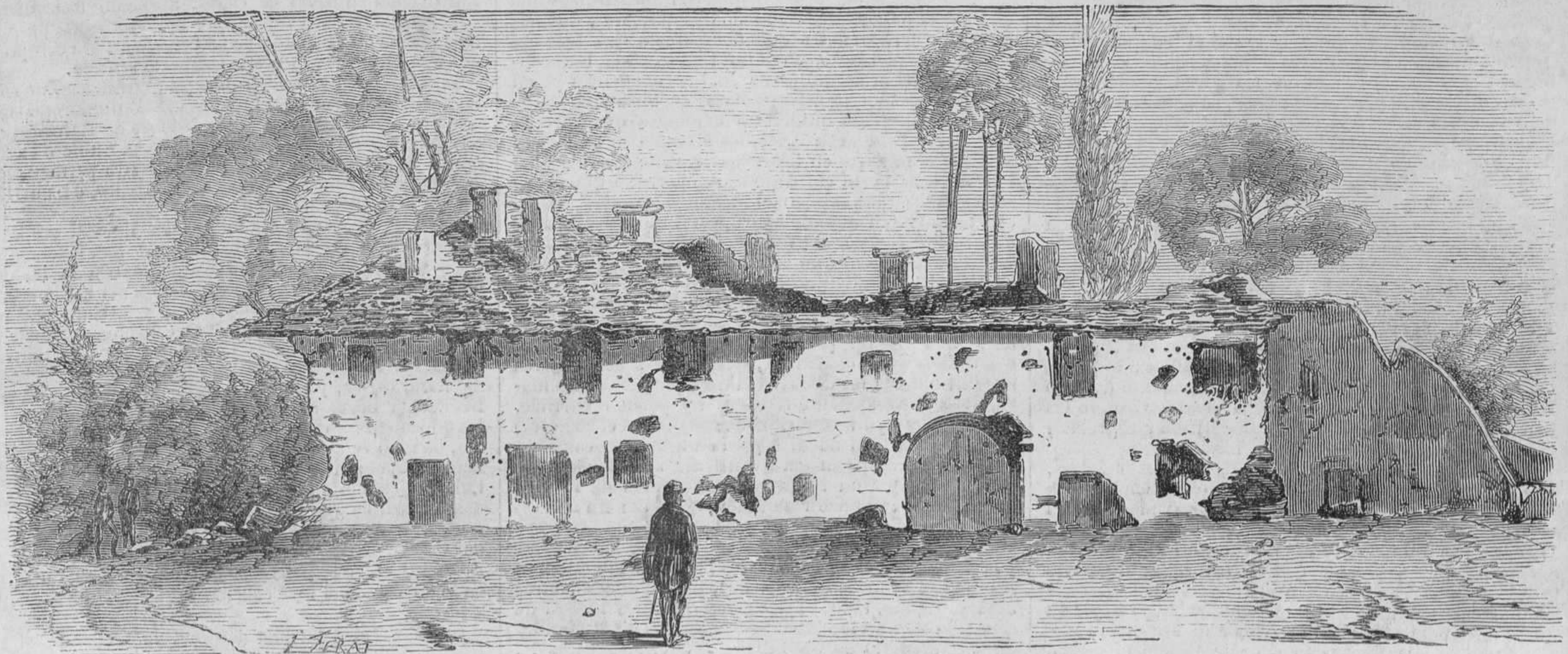
CASAS DE LA ALDEA DE BUFFALORA DESTRUIDAS POR EL CAÑÓN.
