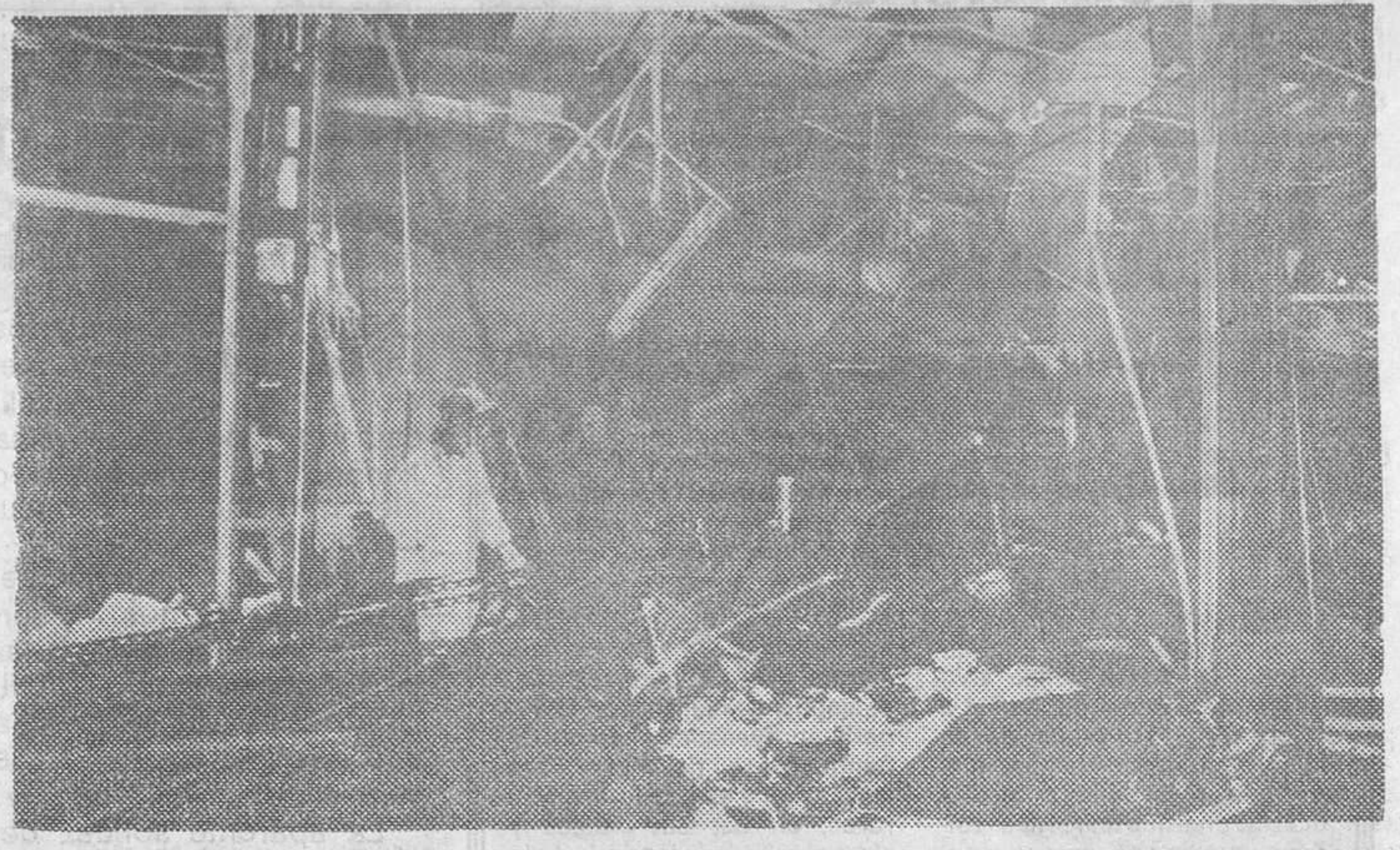
Las instalaciones del aeropuerto madrileño quedaron seriamente dañadas por la onda expansiva de la bomba. — (Foto Efe)
