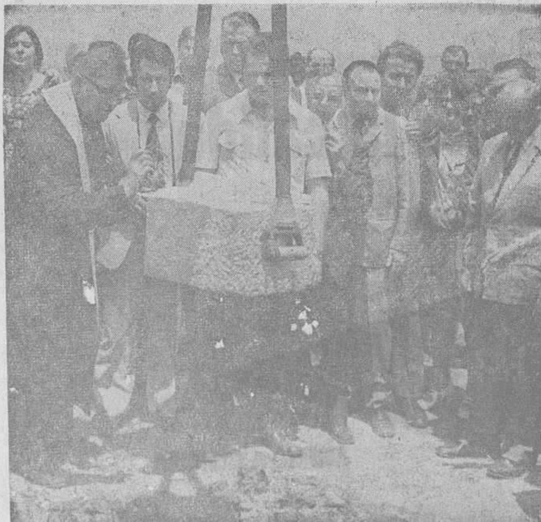
El pasado día 2 de Julio, tuvo lugar el acto de bendición y colocación de la primera piedra del edificio industrial de PANIFICADORA DE BARBERA, S. A. «PABARSA».
