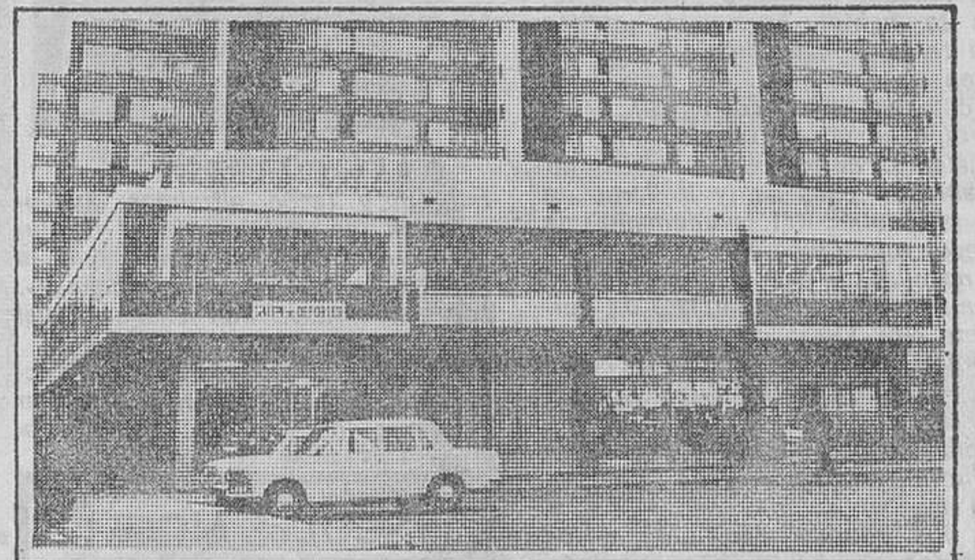
*10 MODULOS EN BELLVITGE 10 módulos como el de la fotografía han sido adquiridos en Bellvitge (Hospitalet de Llobregat). Con una superficie de 15.867 m 2 . Los módulos son los números 2, 3, 4, 5, 7, 11, 64, 66, 70, 71. Total m 2 : 15.867
