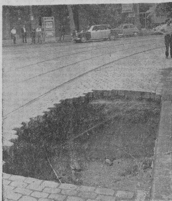
El socavón dentro del que cayó un autobús. Se calcula que el piso falló en una extensión de varios metros con una profundidad de un metro y medio. — (Foto Cifra.)
