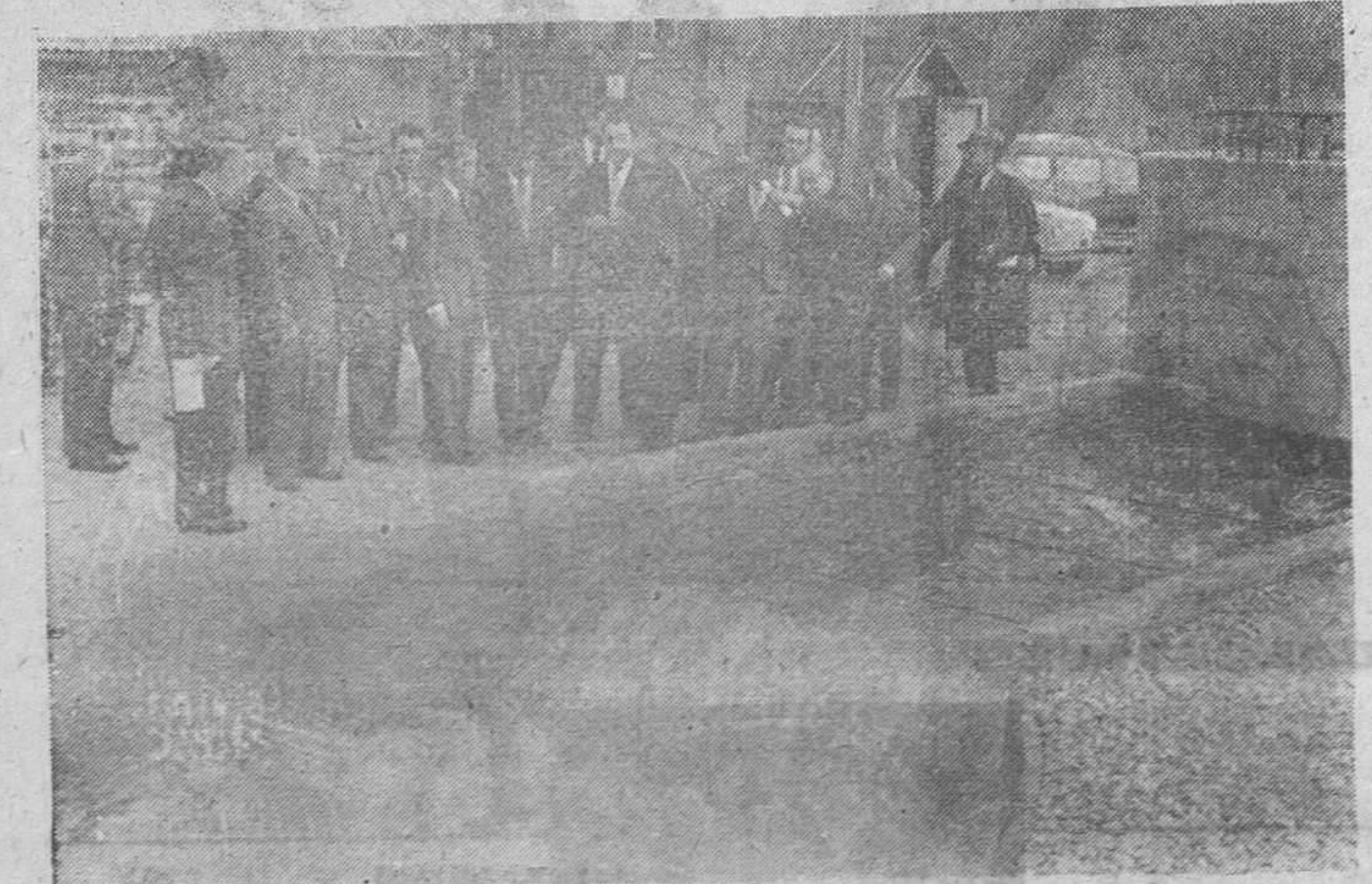
Primer pozo radial abierto en Martorell para extraer el agua del embalse subterráneo allí existente y cuya inauguración fué invitada la Prensa barcelonesa. En la foto inferior, el vertedero de medición del agua extraída, y en la superior, el corto canal que conduce las aguas al Llobregat
